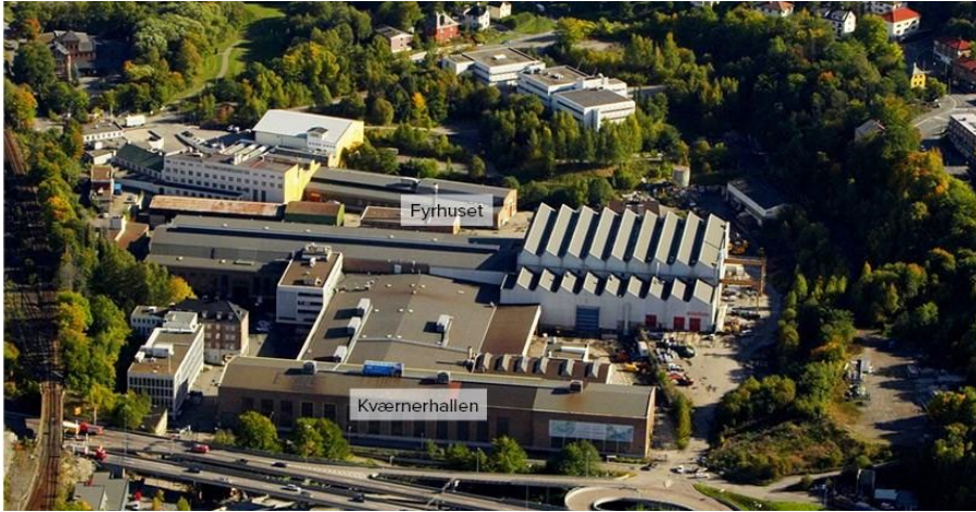
Figur 10: Det gamle industrianlegget i Kværnerbyen i 2005 før det ble revet (OBOS, u.å.c).
