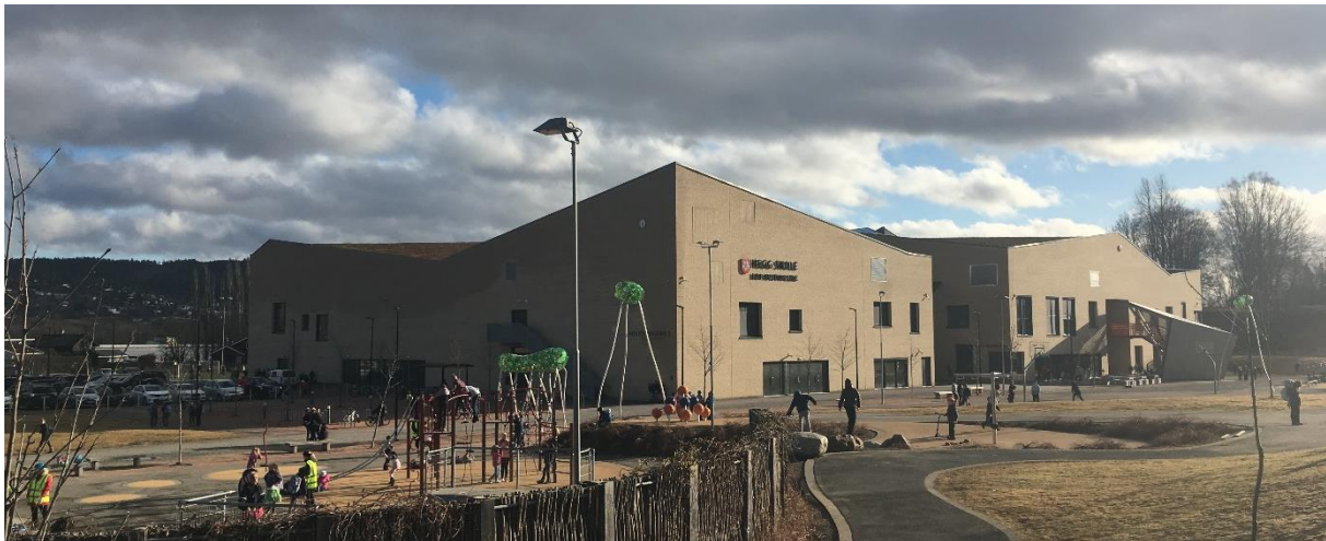
Figur 4-19: Hegg skole: Bildet viser mur-fasaden og takvinklene til hegg skole.
