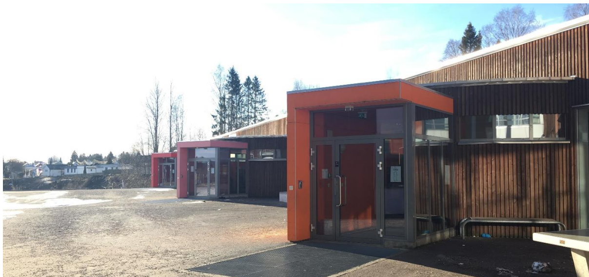
Figur 4-13: Bønsmoen skole: Bildet viser inngangspartiene til tre av hjemmeområdene på Bønsmoen skole.
