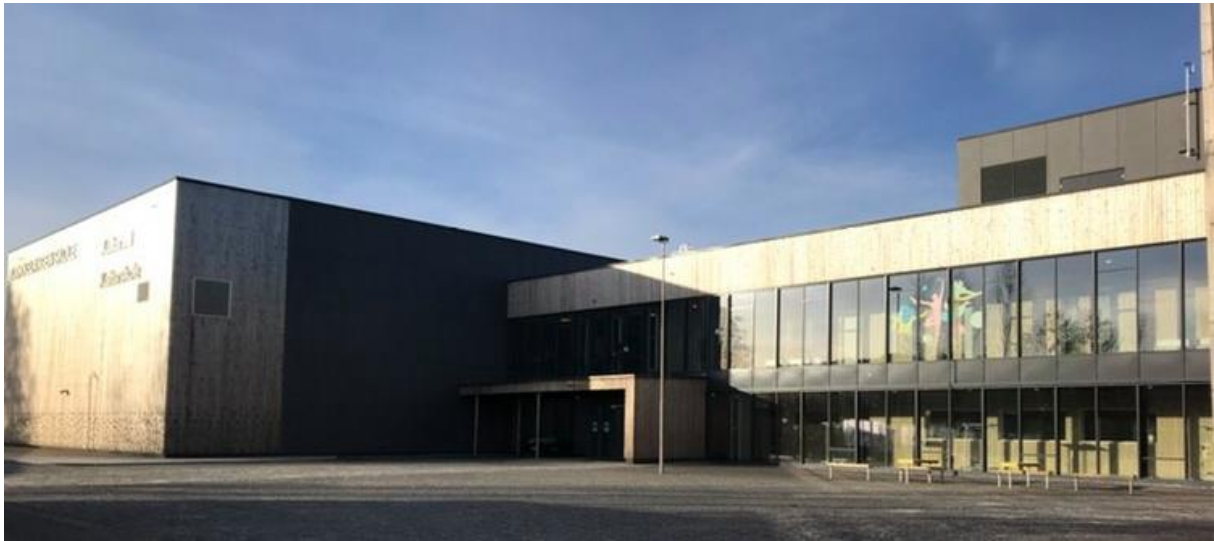
Figur 4-6: Bjørkelangen skole: Bildet viser hvordan en av fløyene stikker ut av midtskipet Bjørkelangen skole. Fasaden består av tre og glass.
