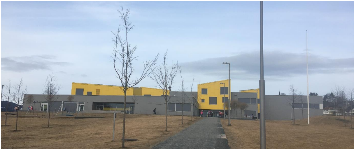
Figur 4-31: Langset skole: Bildet viser Langset skole med grå og gule fasadeplater og vinduer i ulik størrelse.
