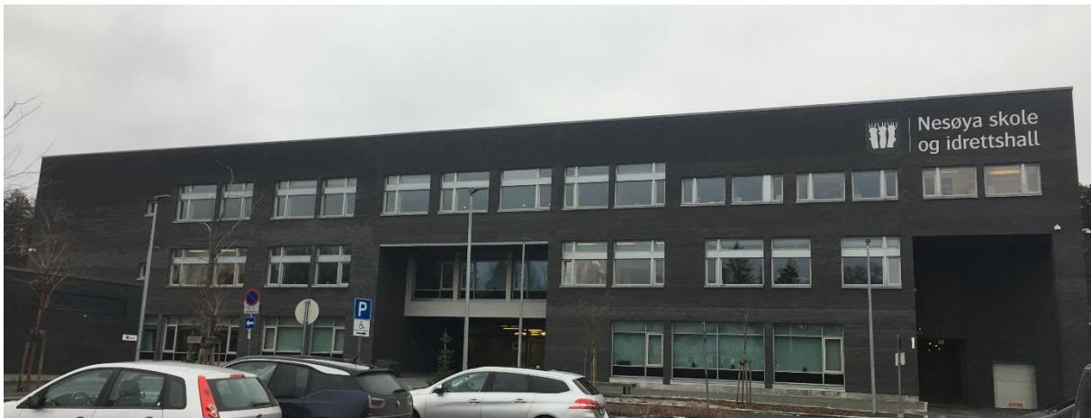
Figur 4-1: Nesøya skole: Bildet viser murfasaden ved hovedinngangen på Nesøya skole.
