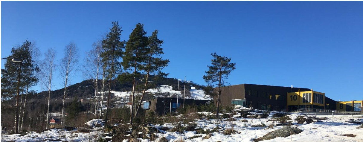
Figur 4-25: Gol skole: Bildet viser Gol skole omgitt av natur, med tre-fasade og eget inngangsparti for hvert trinn.
