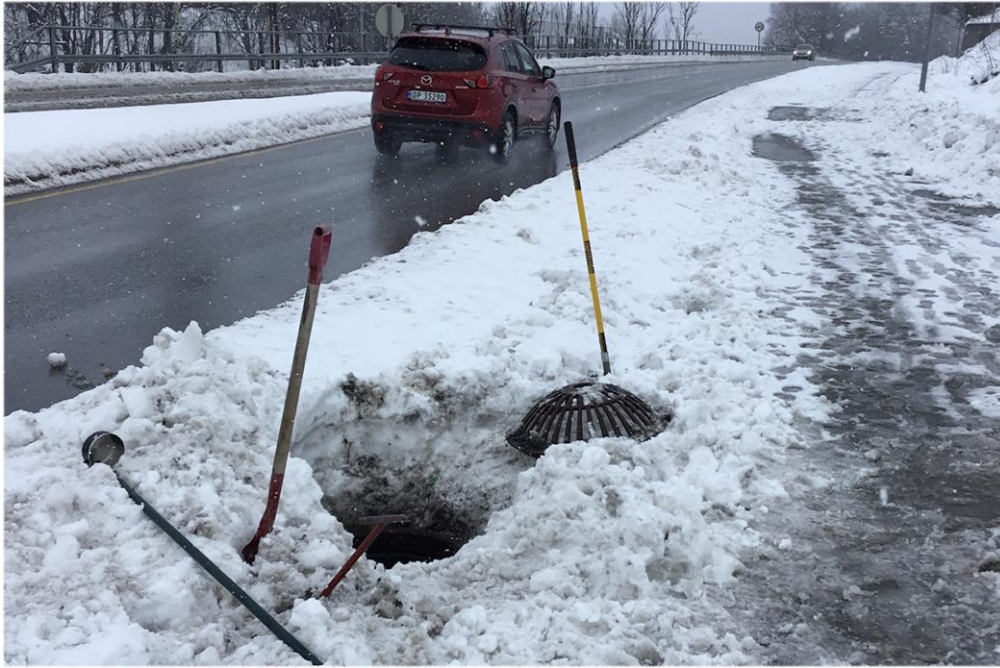
Figur 63 Sandfanget på Drammensvei. Bilde etter utgravingsarbeid
