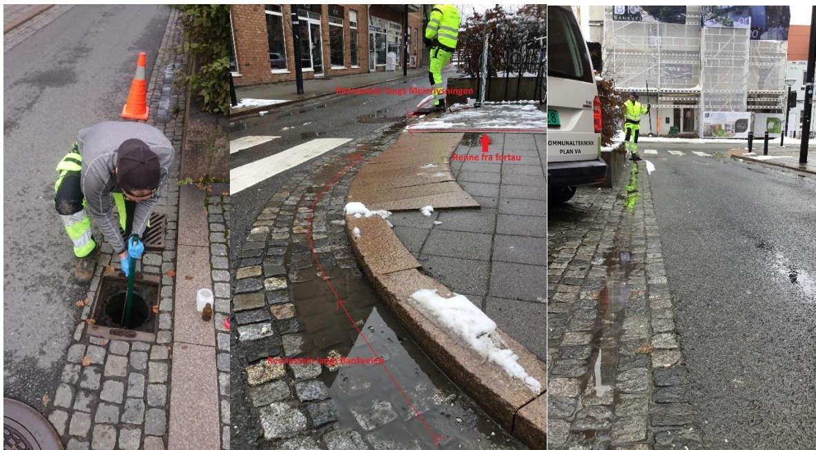
Figur 31 Meierisvingen m/ rennestein fra ulike vinkler hhv 10.10.19 og 04.03.2020
