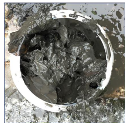
Sandfangsmasser med høyt innhold finstoff samt organisk materiale (her blader) Fra: Meierisvingen
