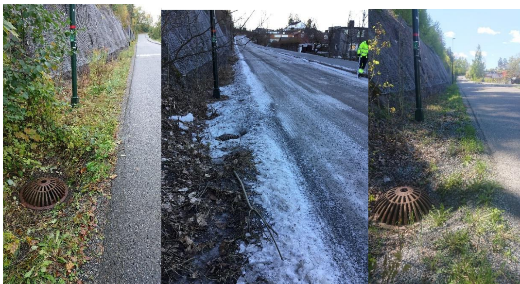
Figur 36 Hovedsluk i grøft v/ Undelstadveien hhv 10.10.2019, 22.01.2020 og 11.05.2020
