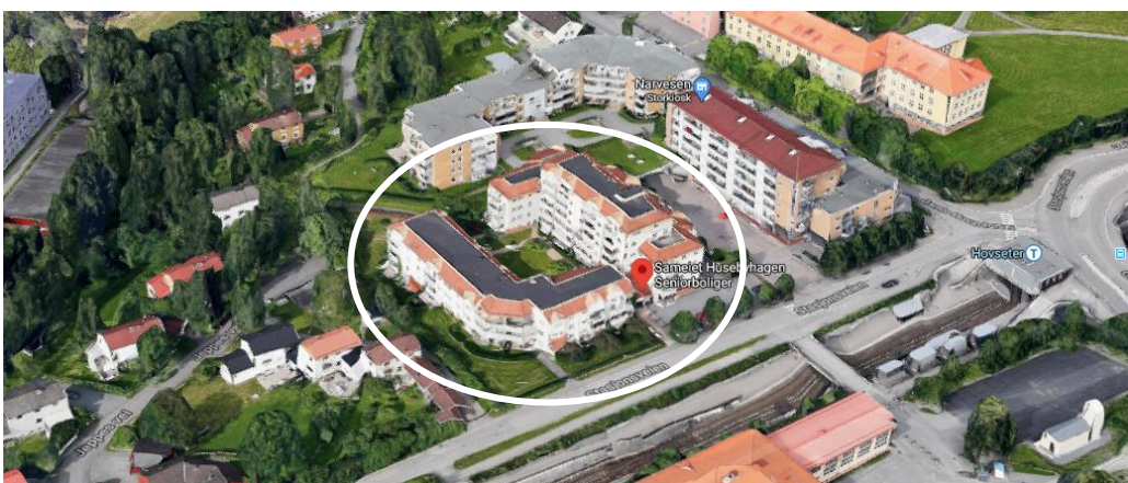
Figur 8. Oversiktsbilde av Husebyhagen Seniorboliger. Skjerm bilde fra Google Maps (2020).
