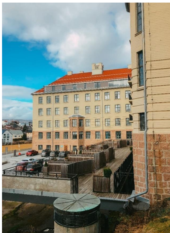
Figur 19. Beboerne deler en felles terrasse. Fasaden er fredet.
