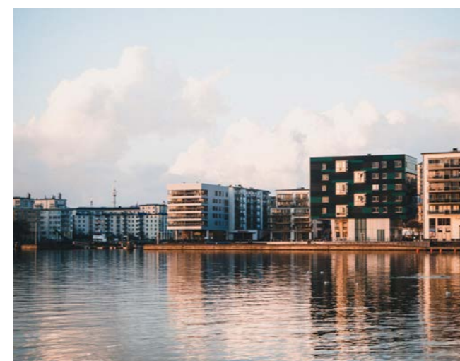
Figur 3.2.9: Bygninger som vender ut mot sjøen. Kilde: Aglo (u.å.).
