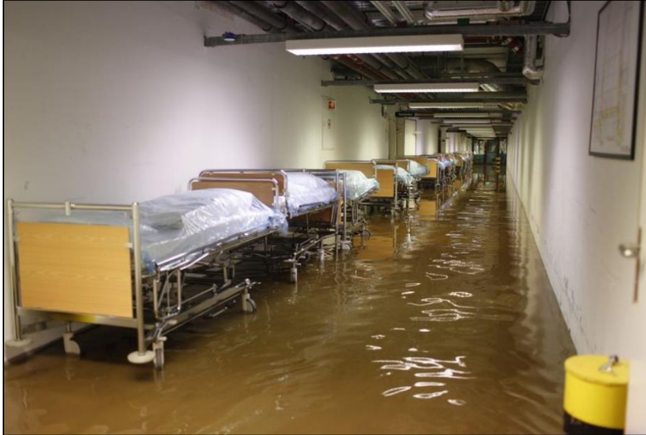
Figur 2-1: Oversvømmelse av Sørlandet sykehus i 2014 som en følge av kraftig nedbør. Foto: Sondre Steen Holvik
