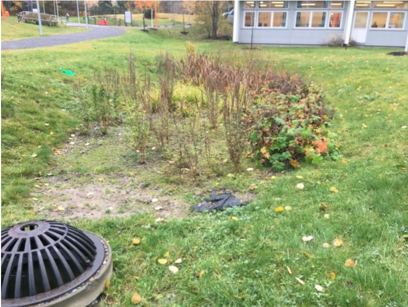
Figur C.5 Infiltrasjonsmåling i JESP 23.10.19.
