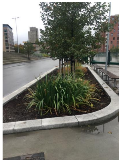
Figur 30 Del av nedbørfeltet til VÅL. Innlaupet er rista som går tvers over regnbedet bak trea.
