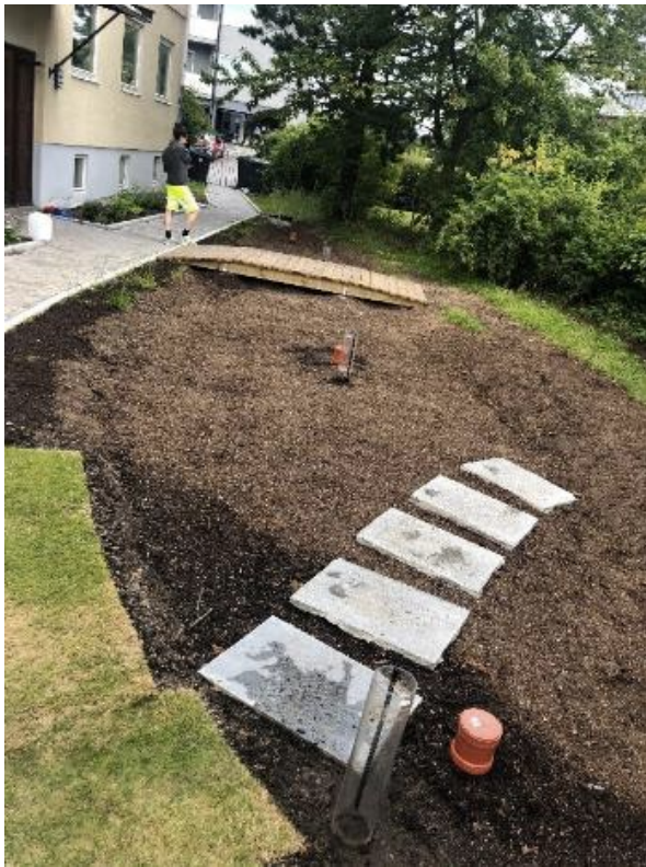
Figur C.12 Infiltrasjonsmåling i GV105 10.07.19. Foto: Nevedda Sivakumar.
