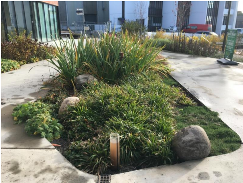
Figur C.3 Infiltrasjonsmåling i ULV 23.10.2019.
