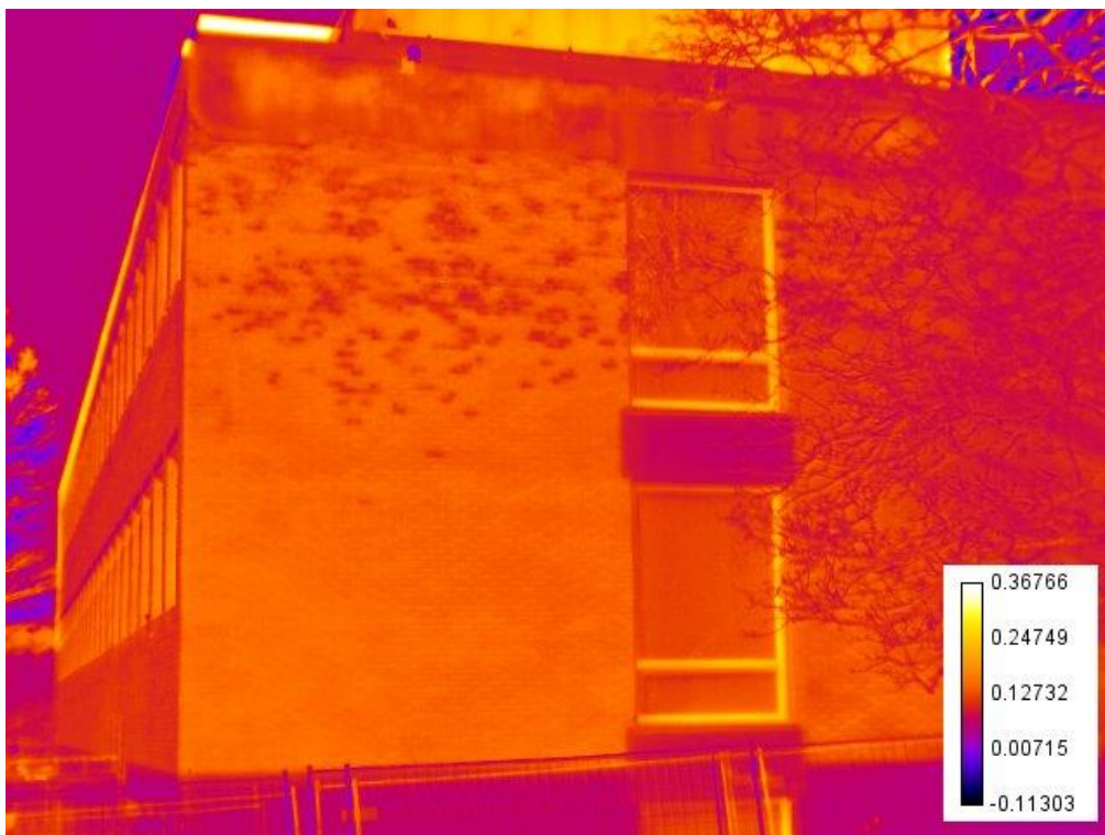
Figur 5.2-6: Termisk fuktfaktor-kart ved passiv termografering
