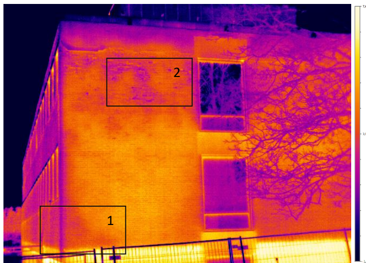
Figur 5.2-3: Termografering utført kl. 05:25. Start passiv termografering.
