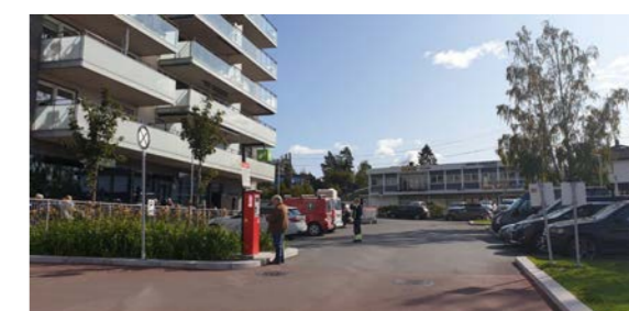
Fig. 230: Like ved torget og kafeens uteservering er det etablert en parkeringsplass.
