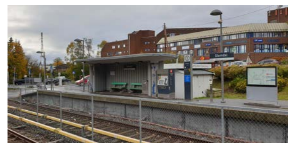
Fig. 121: Vestre perrong sett fra østre perrong. Stasjonspaviljongen med benker fra 50-tallet har fremdeles funksjon som leskur. Handlesenteret i bakgrunnen.
