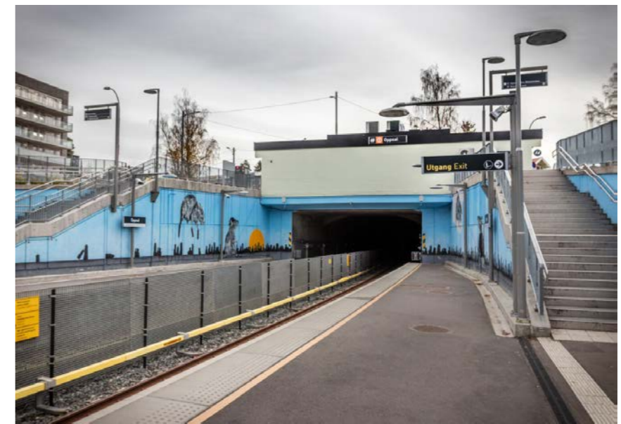
Fig. 216: Oppsal T-banestasjon etter rehabiliteringen og moderniseringen i 2016. Bildet over viser at stasjonen ikke har gjennomgått store fysiske forandringer siden 1967, men bygningen som tidligere var en billetthall har ikke lenger en aktiv fasade og passasje. Foto: Sporveien, 2020.
