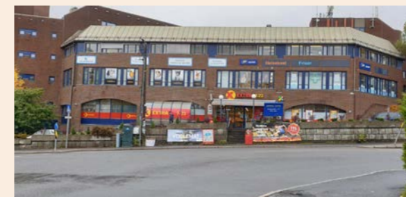
Fig. 133: Det er dårlig forbindelse for myke trafikanter mellom stasjonen og handlesenteret grunnet mangel på overgangsfelt. Murene utenfor handlesenteret kan i tillegg oppleves som en barriere for mennesker som ikke kan benytte trappen. Bildet tatt fra stasjonsområdet.
