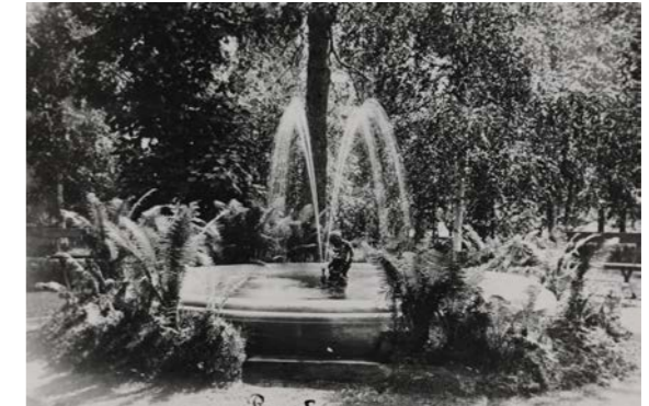
Fig. 79: Rena stasjonshage. Fotografering trolig 1890-1930. Foto: ukjent/Norsk jernbanemuseum, 2019.
