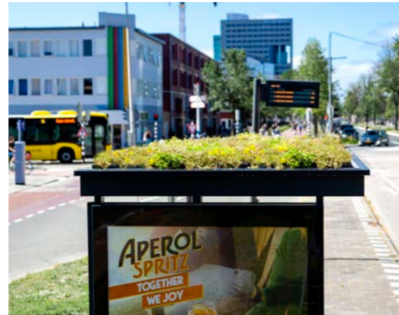
Fig. 87: Lesurene har sedumtak. Foto: Verbij/Clear Chanel, u.å.
