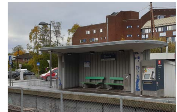
Fig. 118: Stasjonspaviljongen slik den ser ut i dag. Plasseringen er den samme som i 1951.
