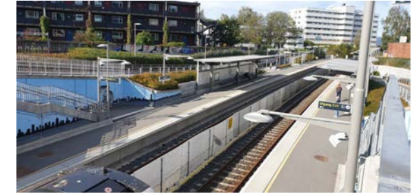
Fig. 218: Stasjonsområdet sett fra østsiden av Narvesen-bygget.
