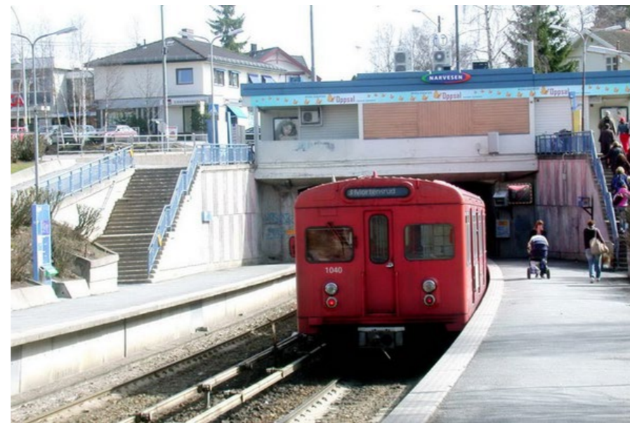
Fig. 215: Oppsal T-banestasjon i 2006. Billetthallen er omgjort til Narvesen-kiosk. Foto: Thoresen, 2006.
