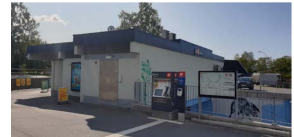
Fig. 220: Narvesen-bygget har en sentral plassering ved oppgangen fra T-baneperrongene i sør, men da det ikke lengre er passasje langs fasaden som vender mot perrongene, kan den oppleves å være et hinder for gående.
