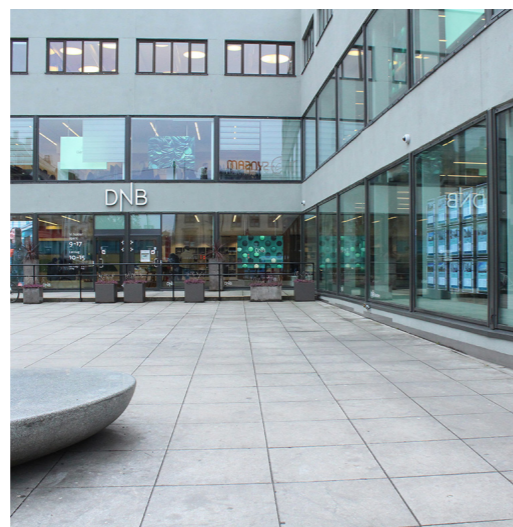
Figur 5.2.7: Fugemønsteret forsterker perspektivet og skaper tydelige linjer som leder blikket mot fasaden til Vinkelgården.
