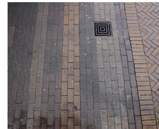
Figur 5.3.14: Mot nordvest markeres overgangen mellom teppet og den øvrige belegningen med striper i ulike teglsteinsfarger.
