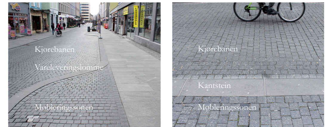
Figur 5.4.10: Møbleringssonen og kjørebanelen grupperer seg persepsjonelt til en enhet på grunn av både likhetsprinsippet og nærhetsprinsippet.
