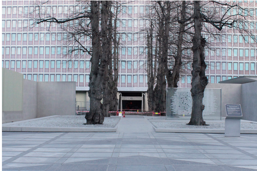
Figur 5.5.7: I front av lindealléen skjer det et brudd i belegningsmønsteret og belegningsstein i mørk skifer danner tydelige spisser som leder mot inngangspartiet til Høyblokka. Bildet viser også hvordan minnesmerket over 22.juli oppleves å stå oppå belegningsmønsteret.
