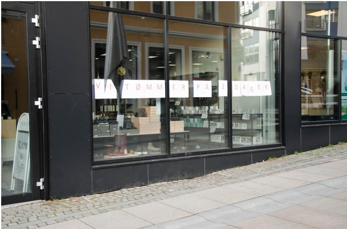
Figur 39: Flere av butikklokalene langs gågaten står tomme og enkelte var i gang med å tømmes. Et økende antall tomme lokaler er et dårlig tegn, og vil på sikt gjøre det mindre attraktivt å bruke gågaten. En ytterligere konsekvens av mindre aktivitet er at området kan oppleves som mer utrygt.
