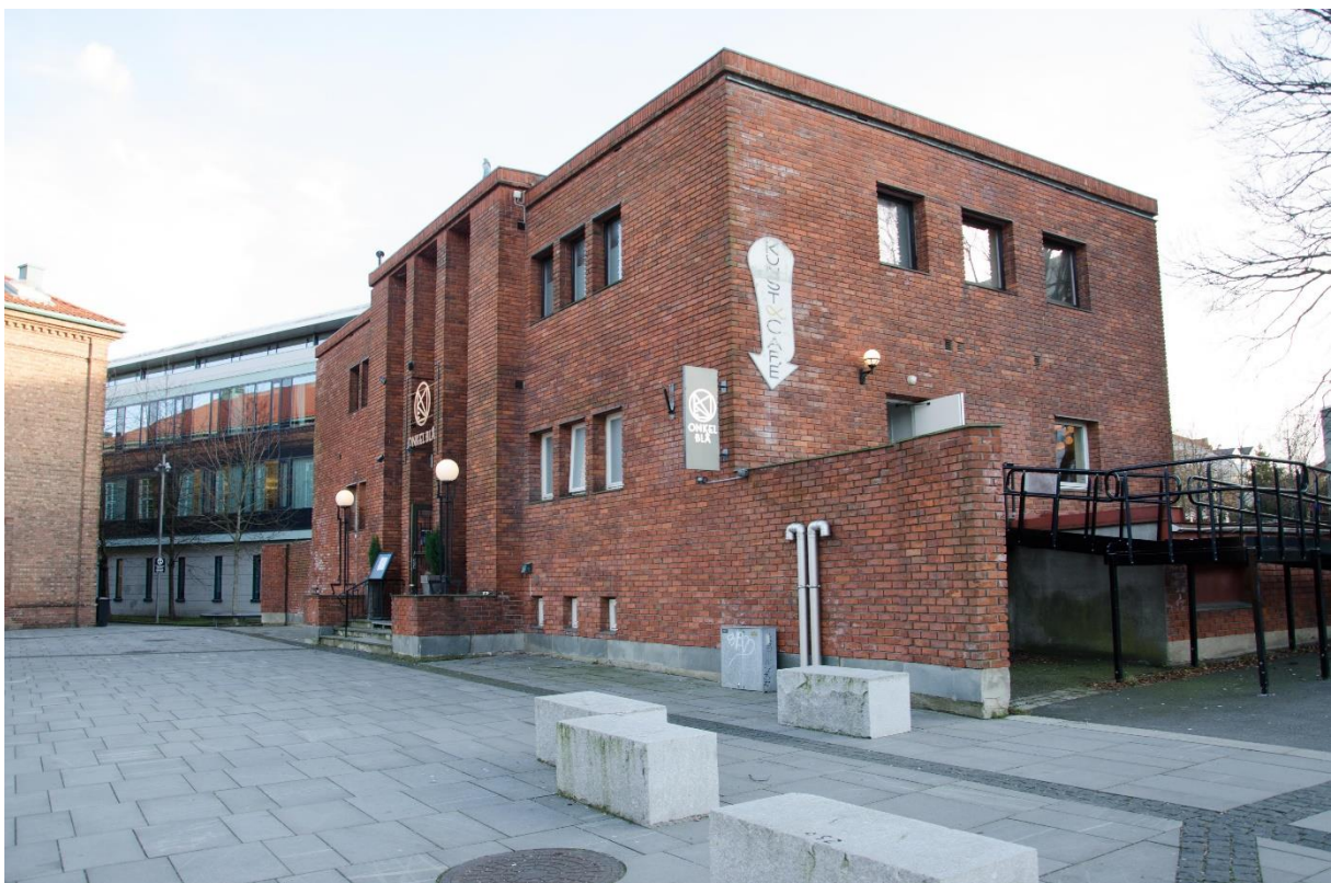
Figur 14: "Onkel Blå" driver serveringsvirksomhet og holder til i bygningen omtalt som "Trygdekassen" fra 1937. På sommeren tilbys det uteservering på plassen foran bygningen. På bildet kan man se ledelinjene som går langs torgets viktigste fedselsårer. Til høyre kan man også se en rampe som sikrer alternativ ankomst til bygget. Granittblokkene sperrer biltrafikk ute fra torget, og kan samtidig brukes til å sitte på.
