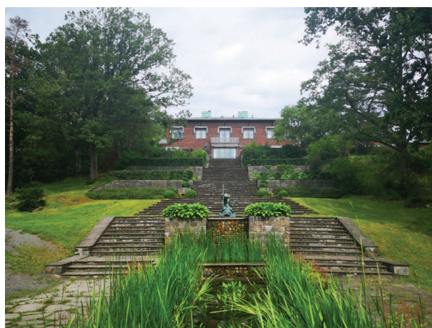
Figur 16: Trappeanlegget sett fra nedsiden.
