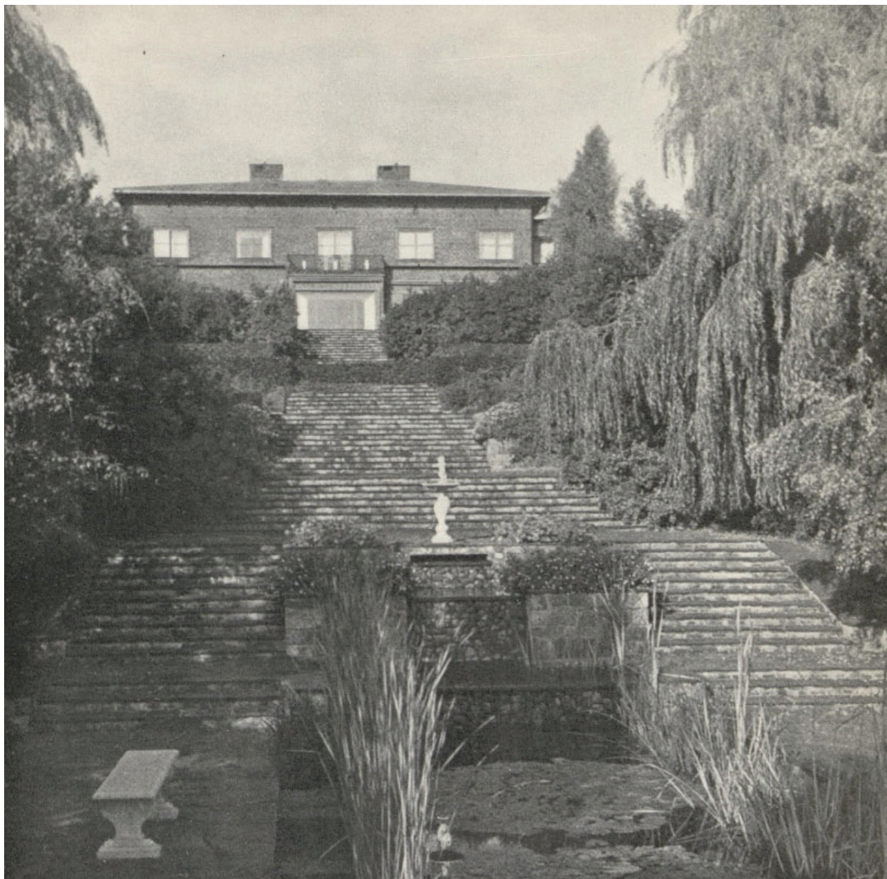
Figur 100: Vannanlegget på Midtåsen (1950-52).
