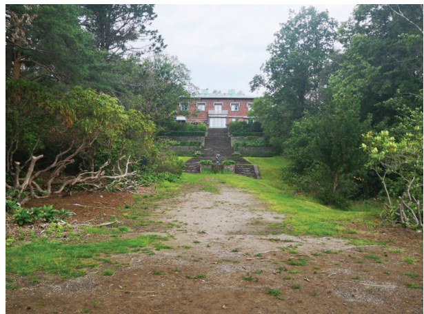
Figur 18: Slitasje på vei mot utkikkspunktet.
