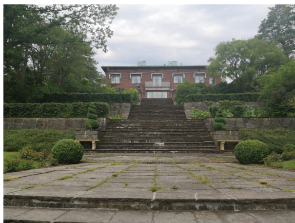
Figur 14: Et halvsirkelformet repos leder ut fra trappen.
