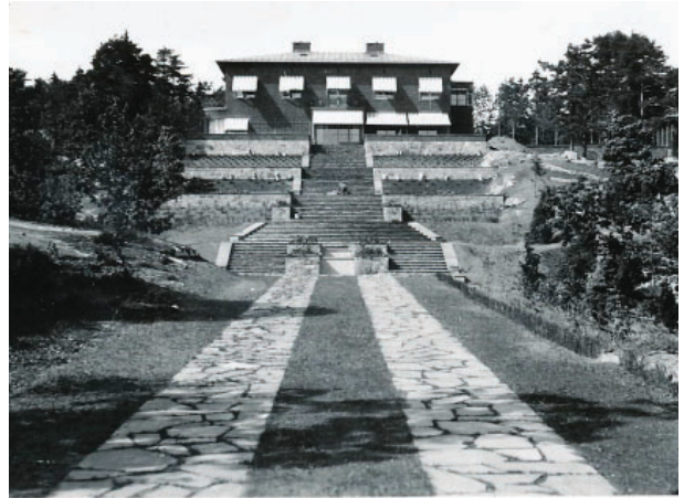
Figur 150: Hellegangene treffer rett på vannanlegget.
