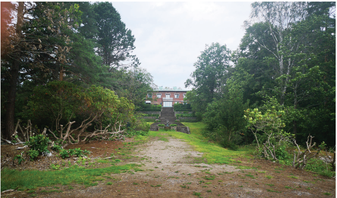
Figur 138: Slitasje i hagen og kraftig beskåret rododendron på hver side av midtaksen (2019).
