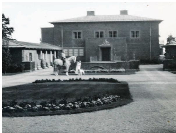
Figur 192: Plantefeltet slik det så ut når anlegget sto ferdig.
