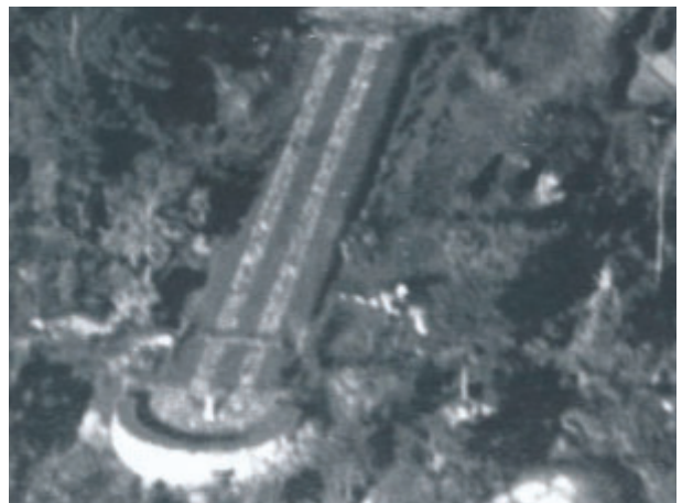
Figur 153: Hellegangene og trappen sett fra luften.
