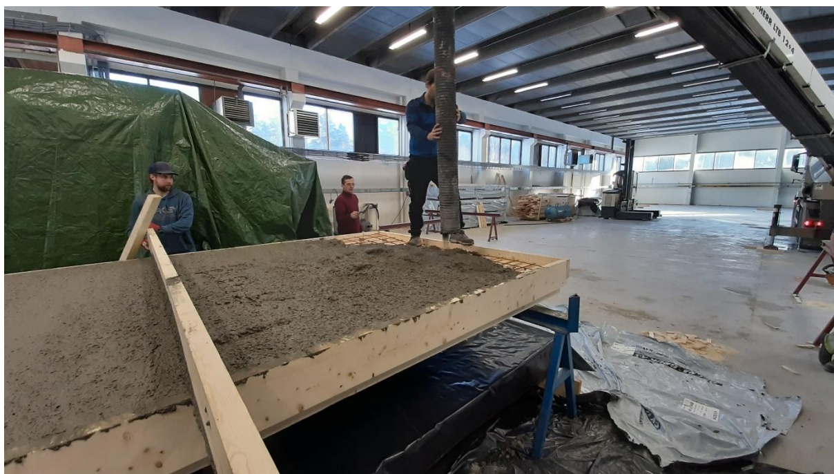
Figur 3.2-15 – Fordeling og avretting av betong.
