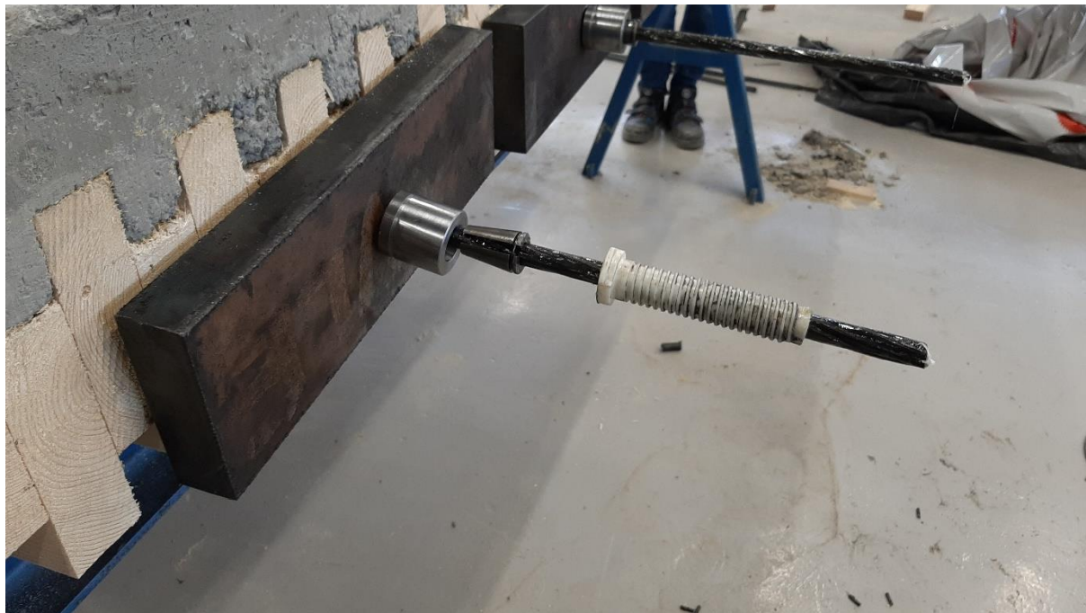
Figur 3.2-18 – Montering av stålplater, hylser og kiler.
