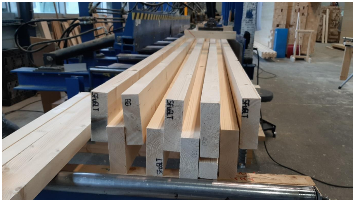
Figur 3.2-4 – Oppsett av et element i jiggen før det blir lagt lekter i sporene i overkant og presset sammen.
