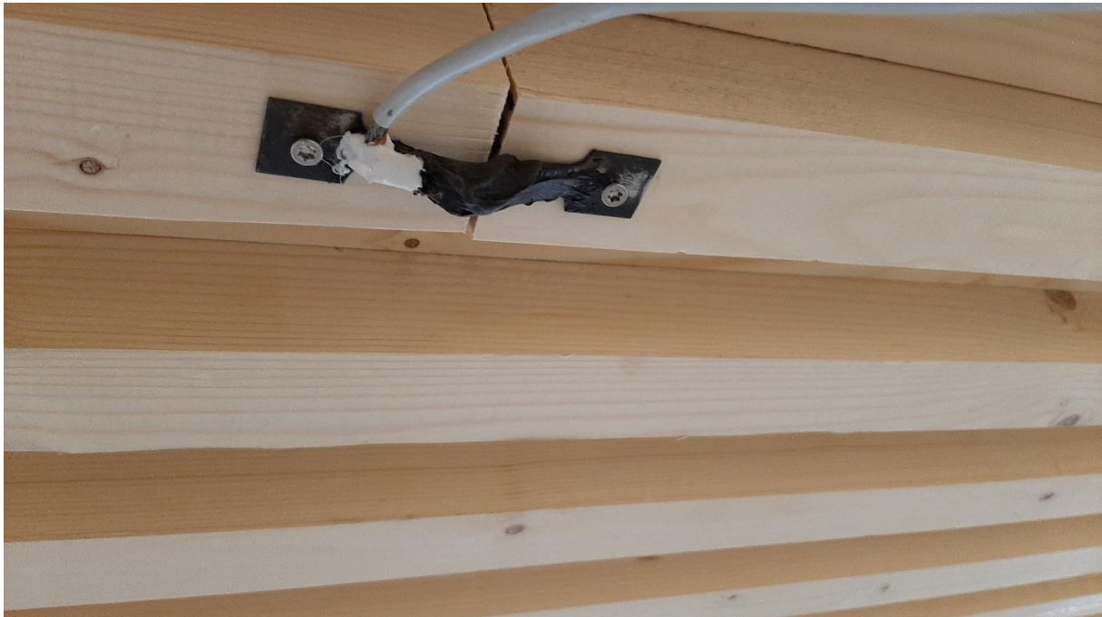
Figur 3.6-11 – Strekkklapp montert over en buttskjøt på samvirkedekket.
