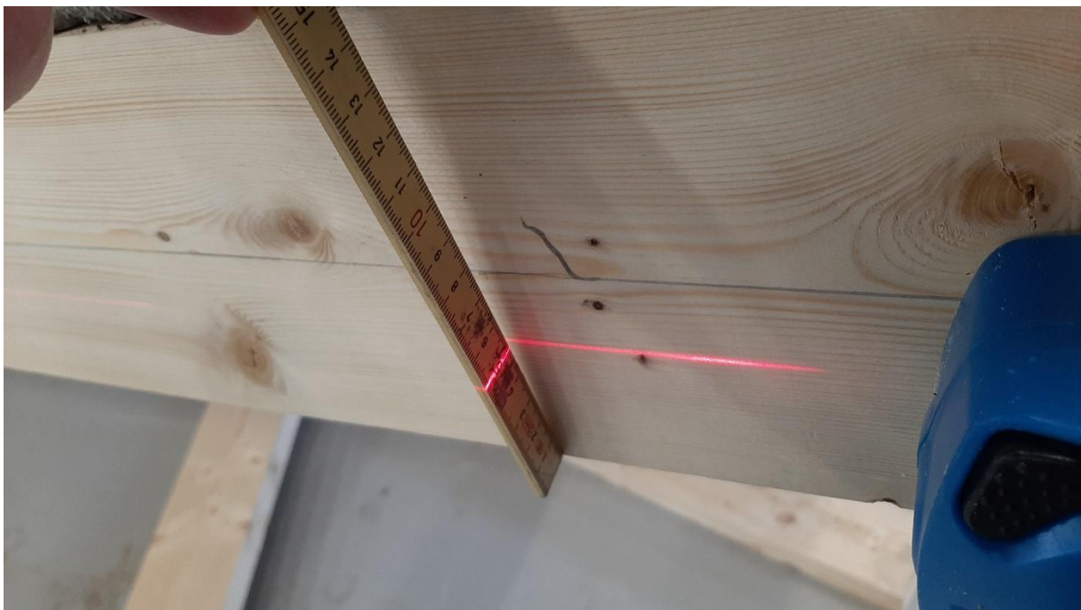
Figur 3.6-4 – Måling av nedbøyning fra egenvekt.
