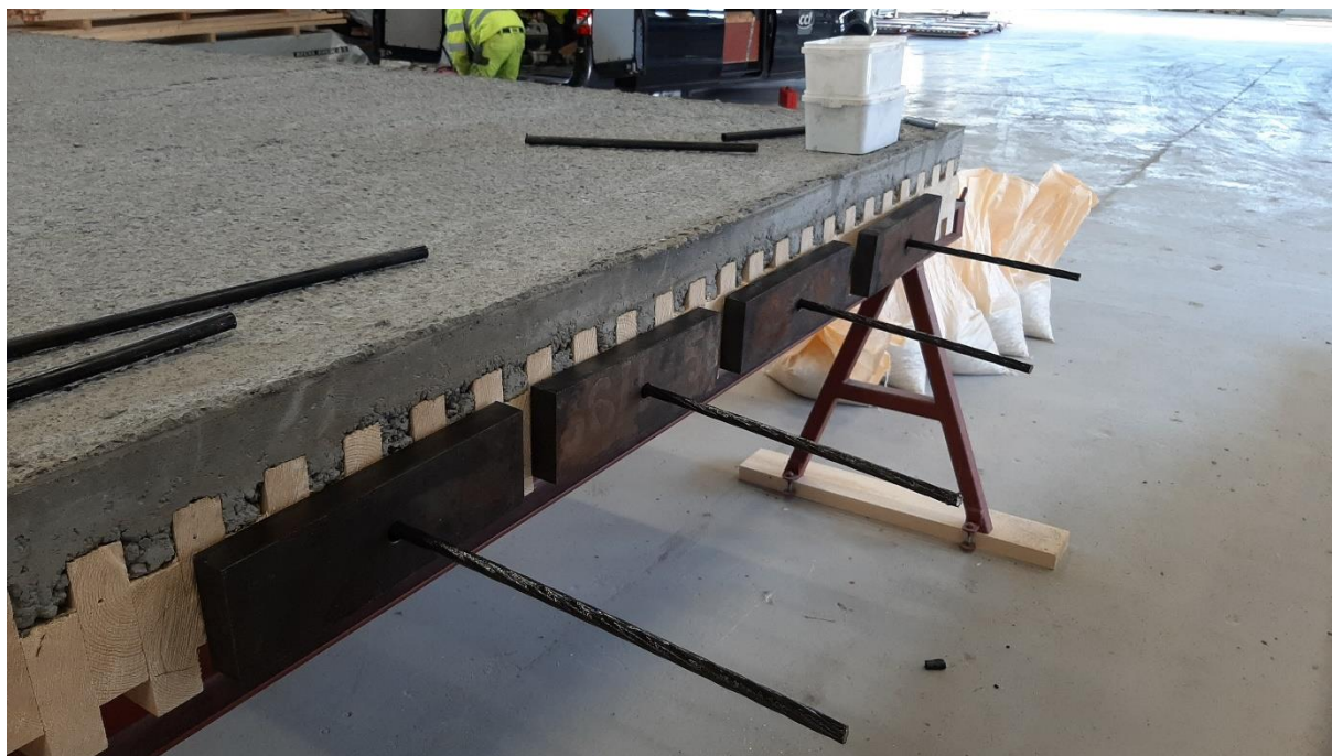
Figur 3.3-1 – Endeplate ført på spennkabel.
