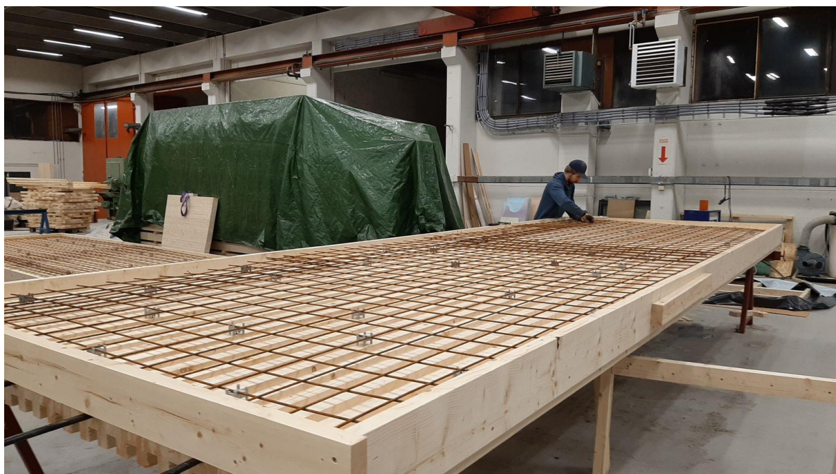
Figur 3.2-14- Viser forskalet og armert dekke 2.
