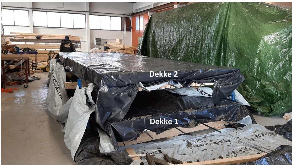
Figur 3.2-16 – Dekkene ferdig støpt og stablet.
