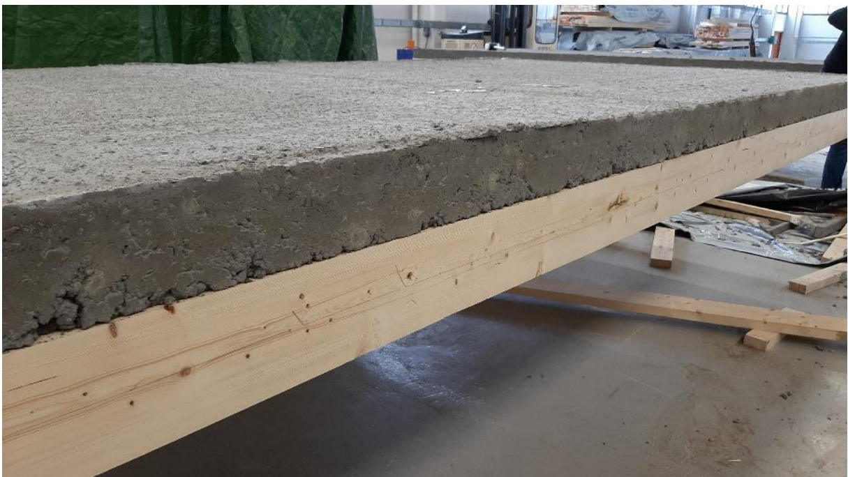
Figur 3.2-17 – Hvordan betongen ligger an på trevirket, langsiden.
