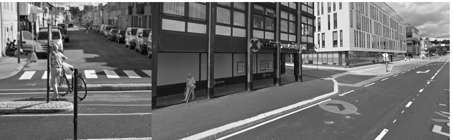
Manglende fortgjengerovergang forringer veivalg for fotgjengere og syklister
