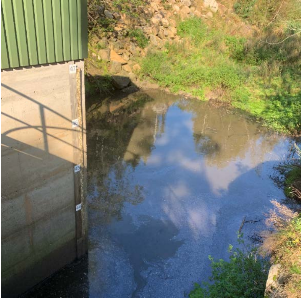
Figur 3.18 Fordrøyningsbasseng ved KP Heftingsdalen
