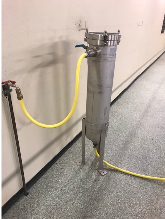
Figur 21: Huset til forfilteret. Foto: Undertegnede
