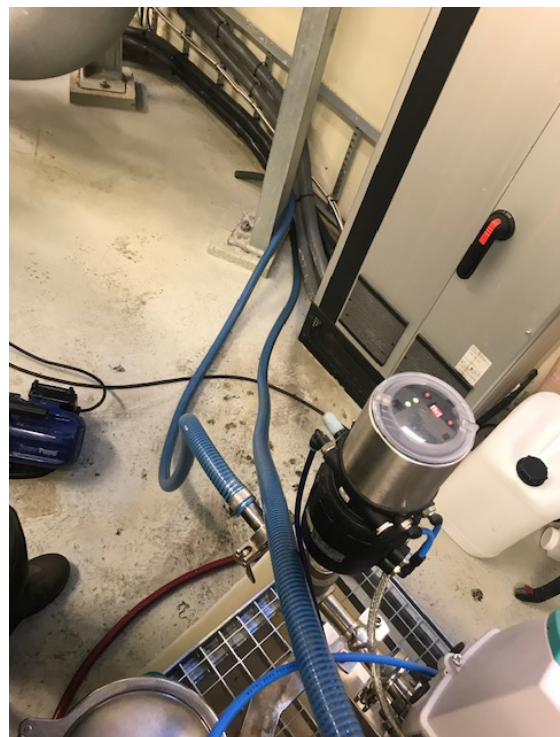
Figur 24: Utløp fra pilotanlegg (konsentrat og permeat) som føres til avløpskum i pumpestasjonen. Foto: Undertegnede.
