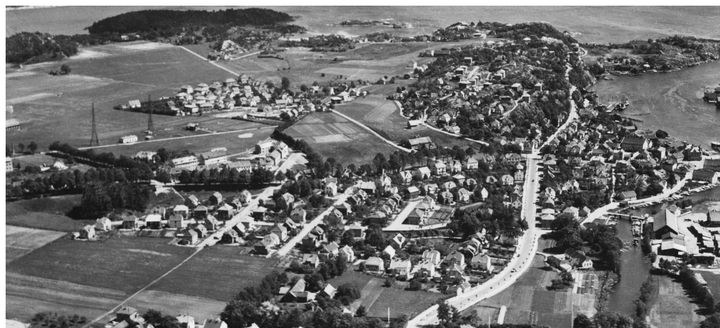
Bilde 4.2: Utviklingen på Lund ca. 1940. Her kommer det tydelig frem at bebyggelsen er inspirert av hagebybevegelsen, med frittstående hus med egen hageflekk i grønne miljøer.
