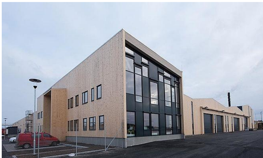
Figur 3-3 Fasade mot nord og glassfasade mot vest på kontordel i KLT hvor de fleste av målingene ble gjennomført. Til høyre i bildet er deler av lagerbygget. Bildet er tatt før montering av måleutstyr.
