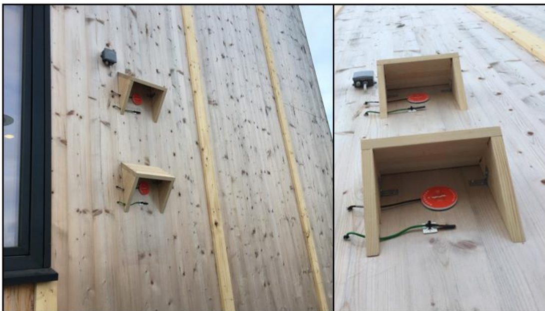
Vedlegg A-1 Utsiden av måleoppsett A (nordvendt)
