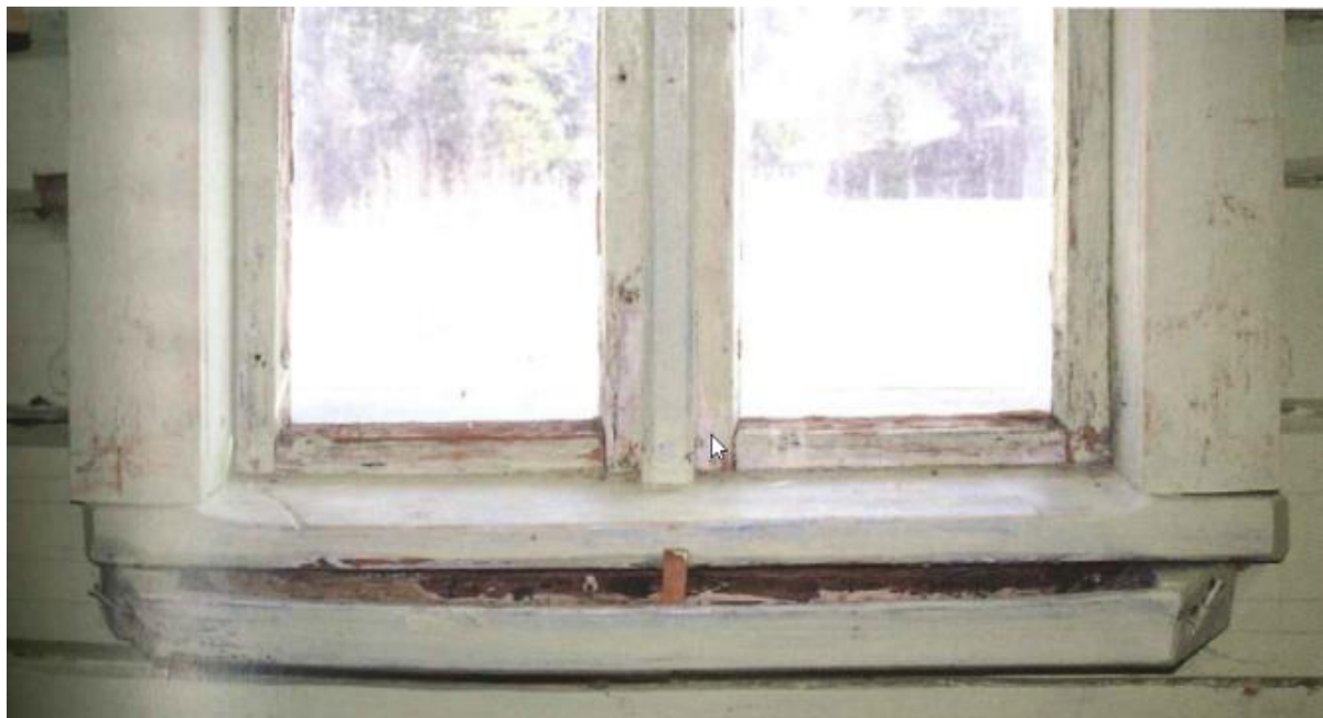
Figur 11 Skrå vindusbenk. Fra «arkitektur i Nord-Norge» av I. Hage, E. Haugdal, B. Ruud og S. Hegstad, 2008, Kvenenes bosetting og byggemåter av I. Hage s. 263. Copyright 2008, Fagbokforlaget Vigmostad & Bjørke AS.
