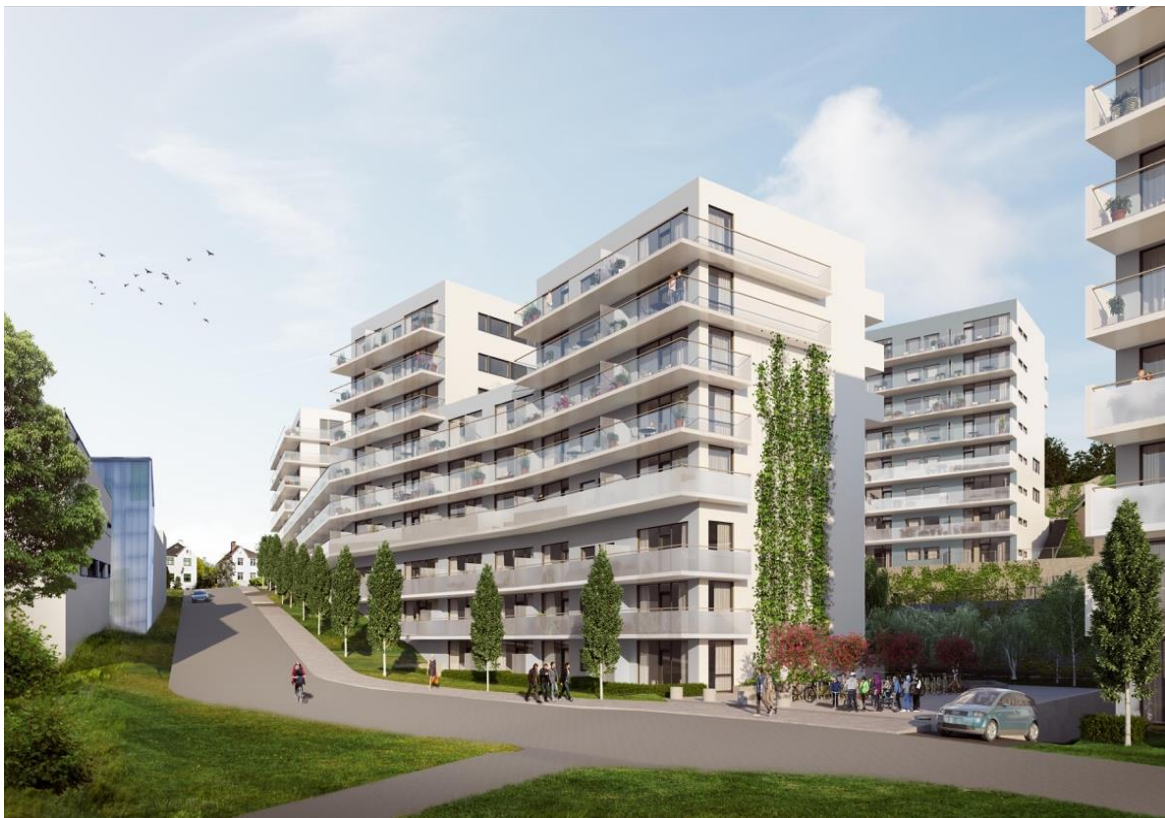
Figur 17 – bildet illustrer grønnvegetasjon på vegg 153 .
