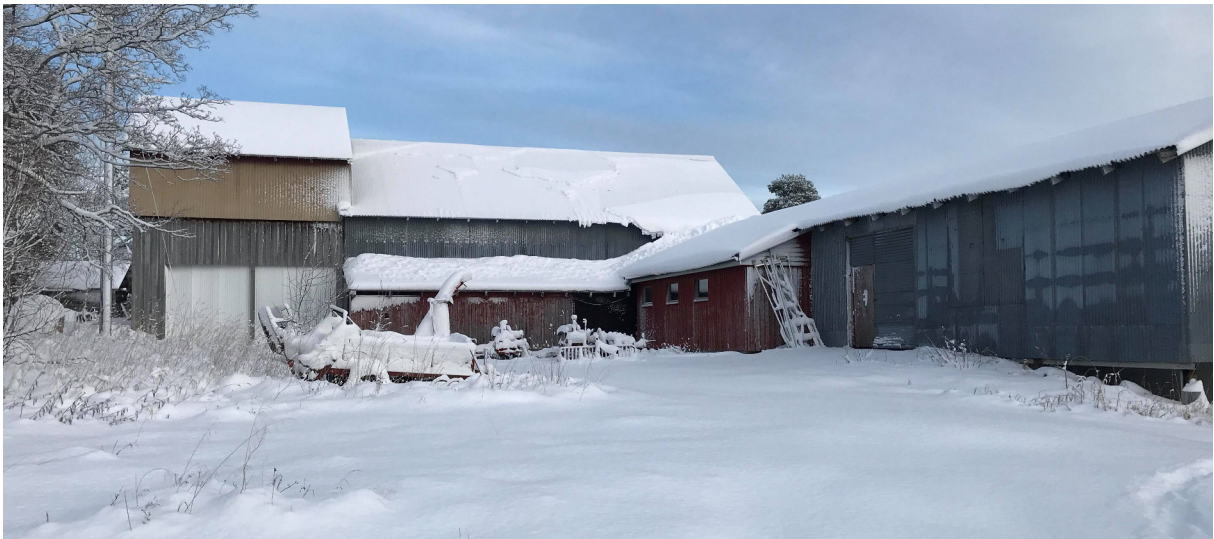
Figur 15: Gårdsplass og eksisterende driftsbygning sett fra nord-vest.
