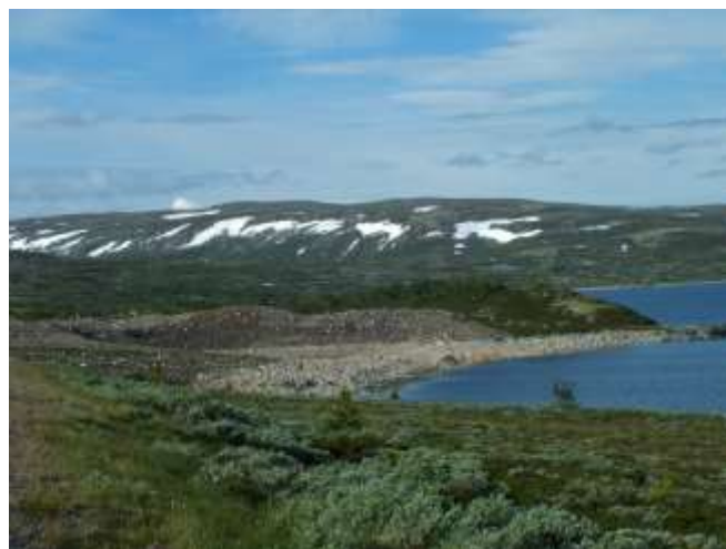
Figur 1. Terrengformingen av steinbruddet tok utgangspunkt i eksisterende terreng og ble plassert i tilknytning til en bratt fjellrygg, og nytt terrenget ble formet ut ifra den naturlige hellingen på stedet (Pedersen, 2012).
