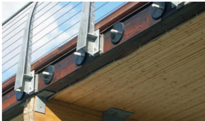
Figur 3.2: Bilde av et tverrspent dekke. (Treteknisk, 2007)
