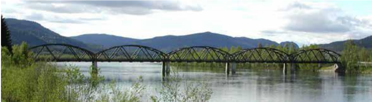
Figur 3.1: Evenstad bru (Statens vegvesen, 2017)
