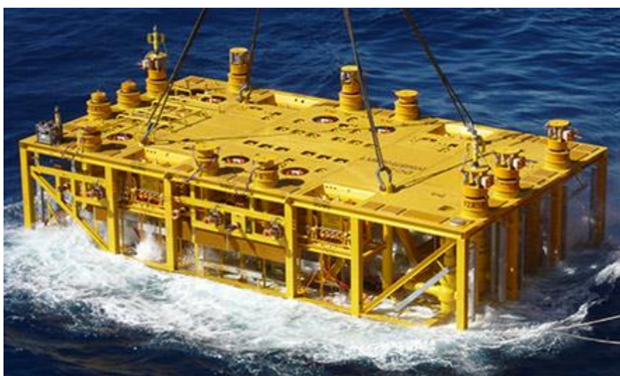
Figur 3: Bilde av komplett subsea-manifold med utvendig ramme som senkes ned sjøen [3].
