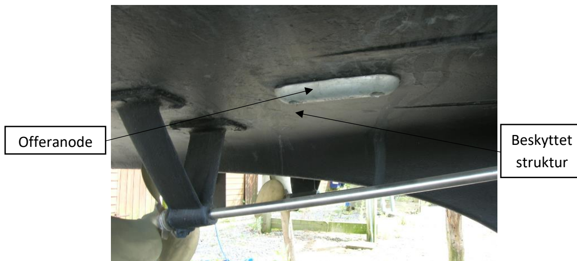
Figur 6: Bilde som viser katodisk beskyttelse i praksis. Her ser man en sink- aluminiumsanode (offeranode) sveiset fast til undersiden til av korrosjonsutsatt skipsskrog [13].
