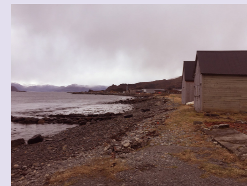
Naust i strandkanten. Potensiale for kyststi og opprustning av naust som kan brukes av allmenheten.
