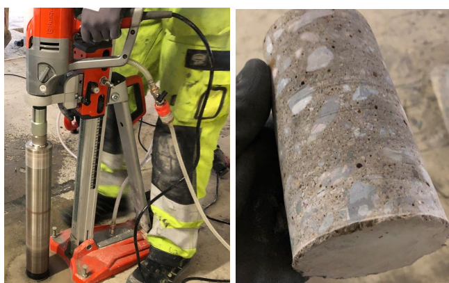
Figur 3.6: a) Kjerneboring b) Utboret betongkjerne
