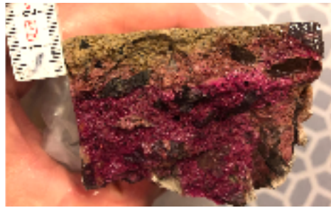
Figur 4.1: Karbonatiseringsdybde hvor betongprismene ble skåret ut
