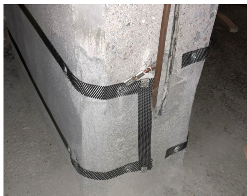
Figur 2.26: Båndanode over reparasjon i bunn av søyle (Privat foto)
