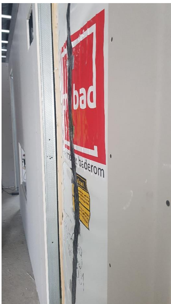
Tetting av baderomskabin
