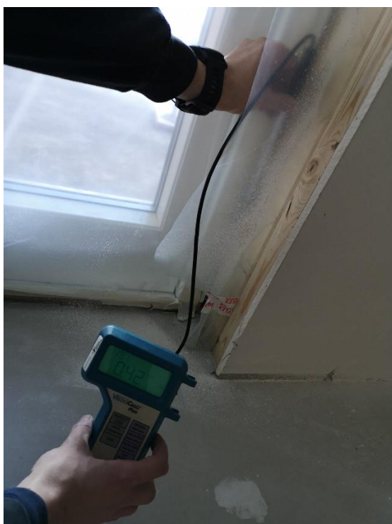
Lekkasje fra balkongdør (0.42m/s)
