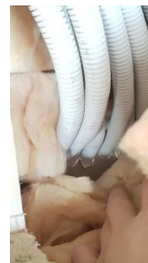
Figur 47 - Samling av K-rør med isolasjon Foto: Edvard Hogstad
