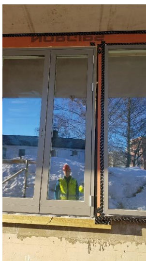
Teiping mot dekke i overkant
