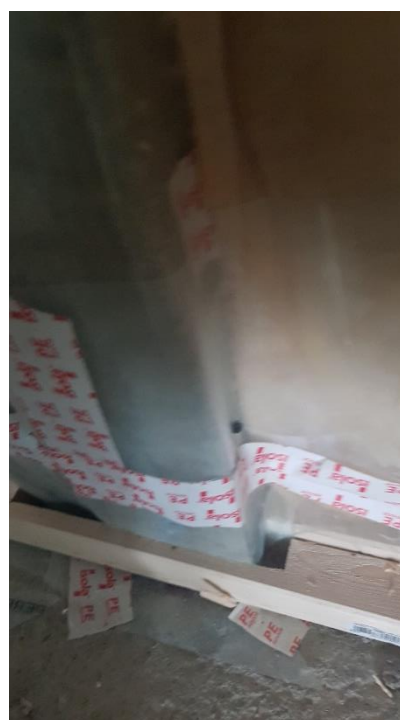
Bruk av gipsskruer for å holde diffusjonssperre på plass
