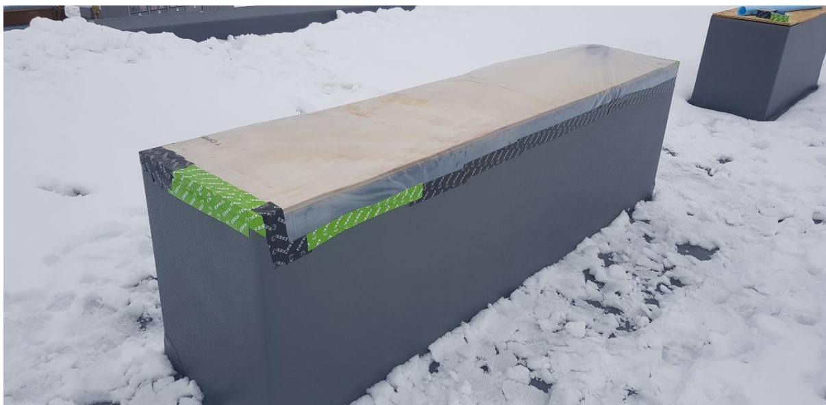
Provisorisk tetting av sjakt
