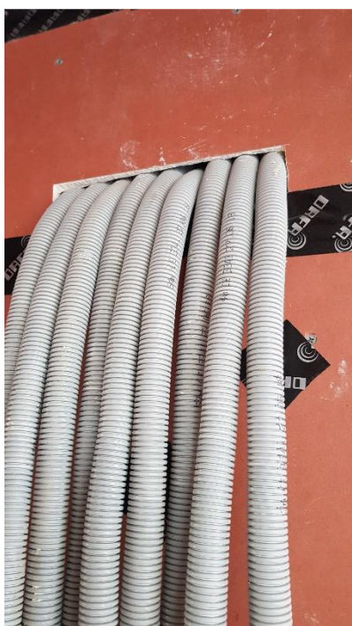
Gjennomføring av k-rør utside
