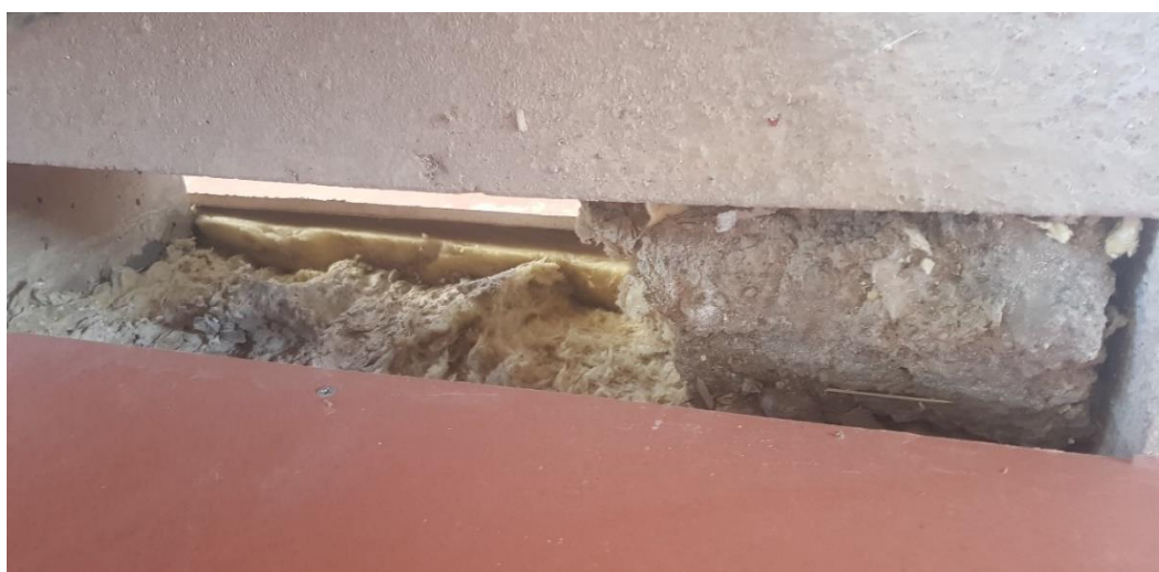
Utsparring for EL på svalgang vanskeligjør tetting
