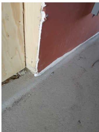
Fuget mot dekke
