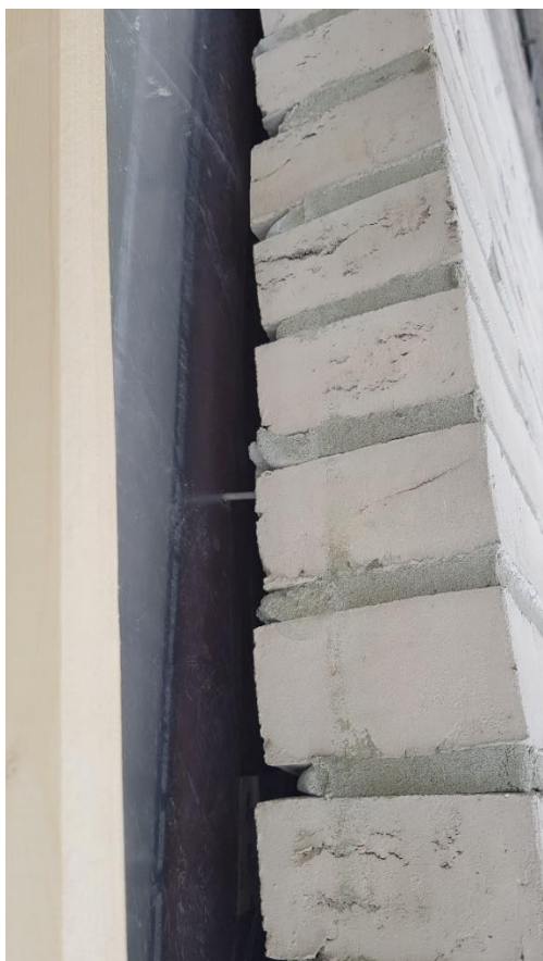
Teglsteinvegg forankres gjennom vindsperre
