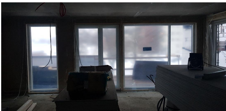
Diffusjonssperre på vegg mot balkong
