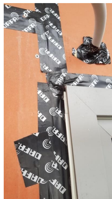
Svak teiping av gips mot vindu
