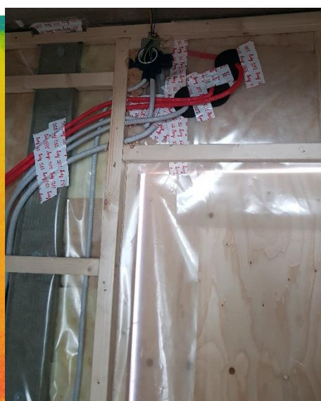
Lekkasjer ut av gipsskjøt (0.79 m/s) og stikkontakt over inngangsdør (0.91 m/s). Bilde til høyre viser hvordan det ser ut bak gips.
