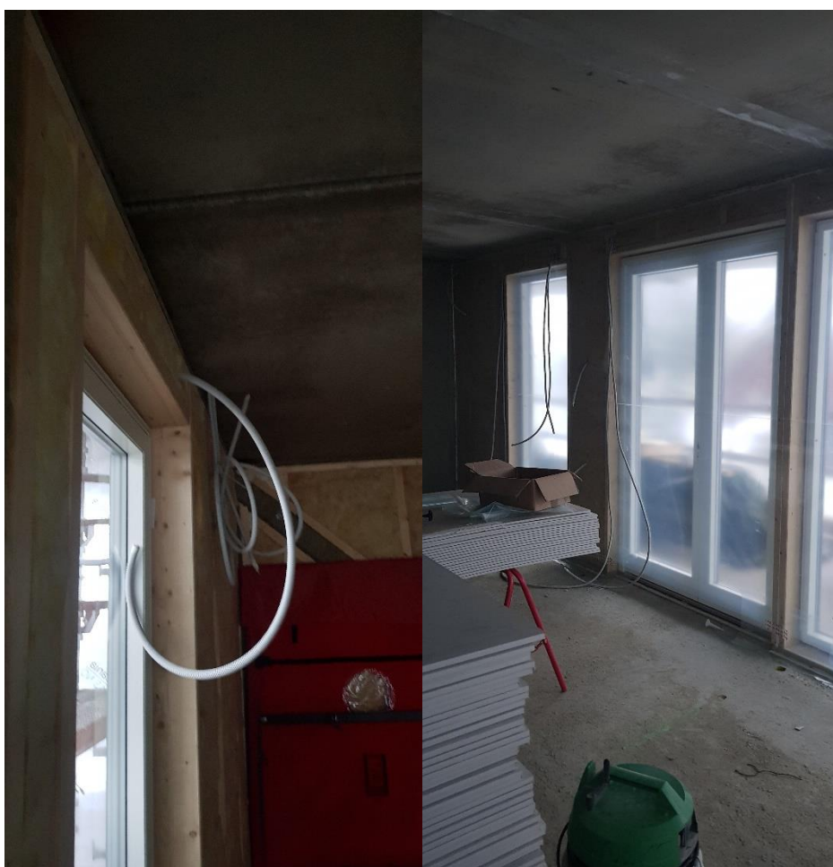
Ikke fuget mot dekke
