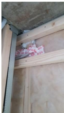
Figur 52 - Teipet gjennomføring Foto: Edvard Hogstad
