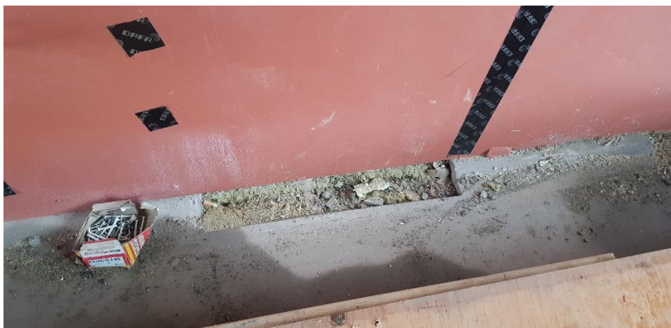
Ikke fuget mot dekke
