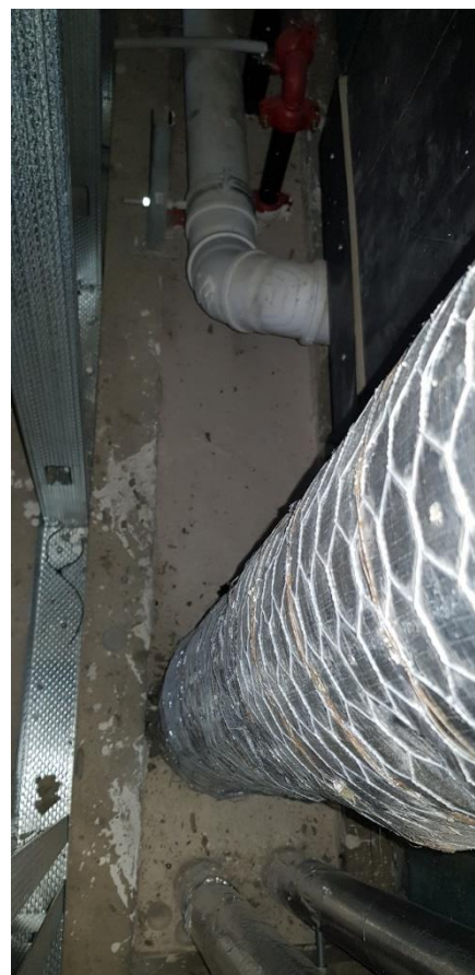
Branntetting av sjakt
