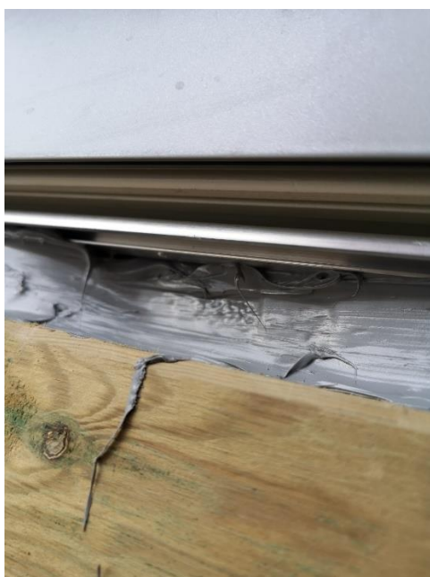
Ser bunnfyllingslist gjennom fug. Svak tetting
