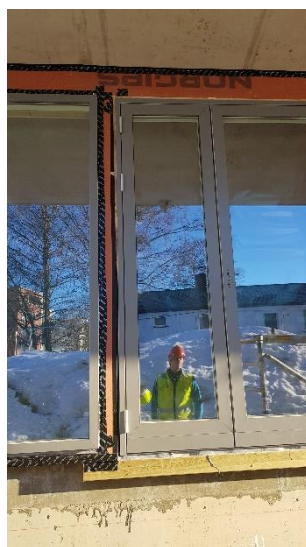
Figur 34 - Fug under vindu og teiping av vindsperre mot dekke Foto: Edvard Hogstad
