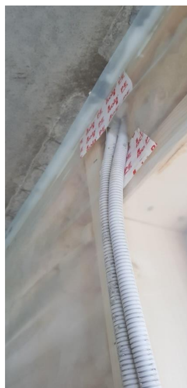
Mangel på mansjett grunnet lite plass. Uheldig løsning
