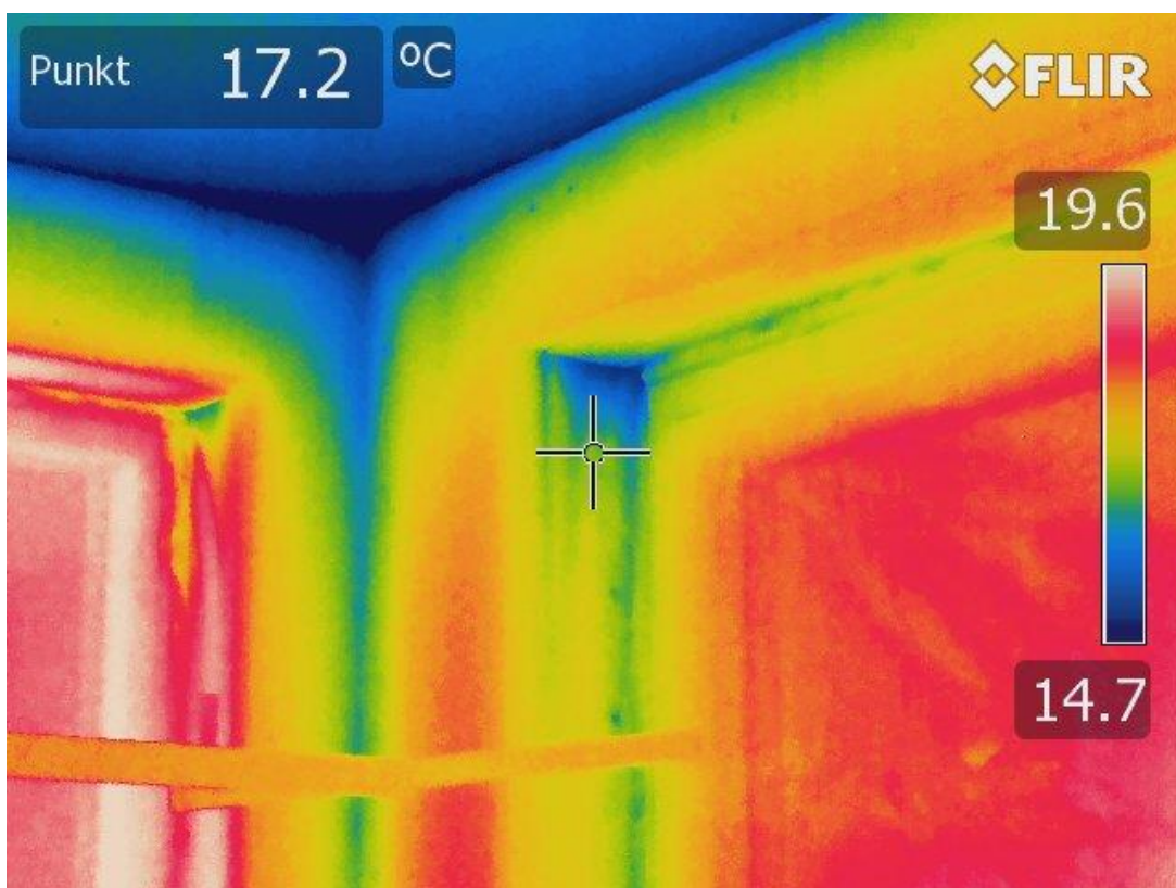
Kald luft strømmer lekker inn mellom stender og losholt
