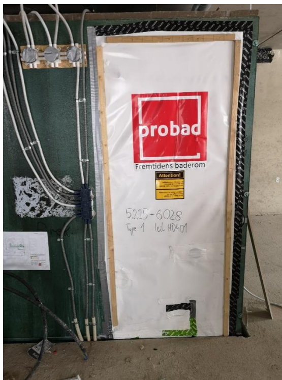
Tetting av baderomskabin
