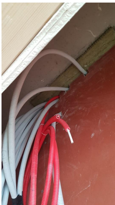
Samling av k-rør kommer til el-rom på svalgang fra leilighet
