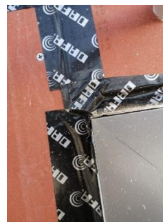
Figur 55 - Teip av vindsperre, leilighet 201 Foto: Edvard Hogstad
