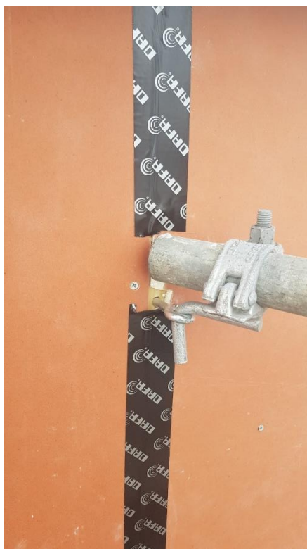
Teiping mot stillasforankring
