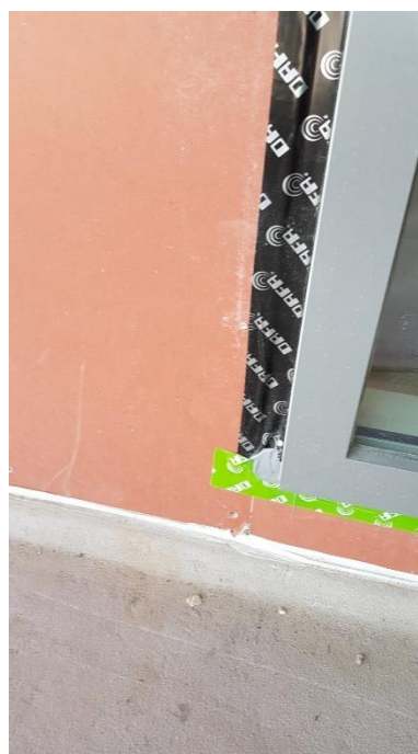
Fuget mot dekke
