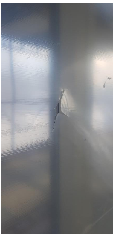
Skåret hull i diffusjonssperre, ettersom denne er trukket forbi vindu
