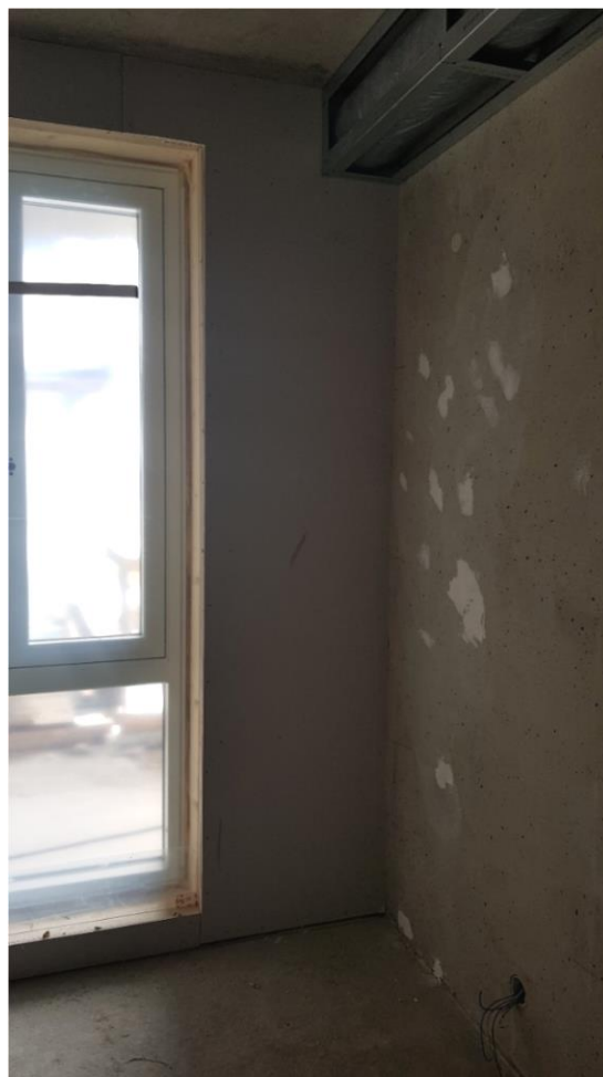
Begynt å sparkle vegg betongskillevegg
