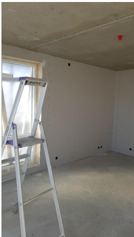
Lekkasjer fra stikk i yttervegg
