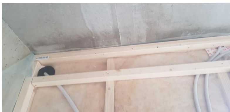
Bilde tatt før montering av gips
