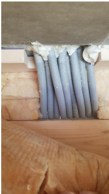
Gjennomføring av k-rør innside
