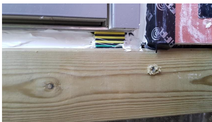
Åpninger inntil høydeklosser for dør
