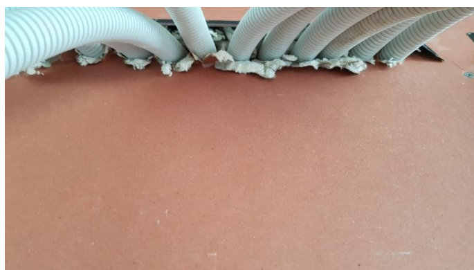
Tetting av K-rør utside
