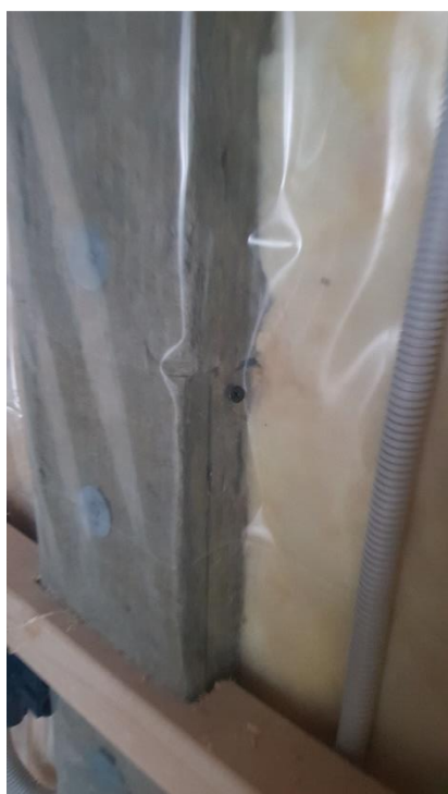
Bruk av gipsskruer for å holde diffusjonssperre på plass
