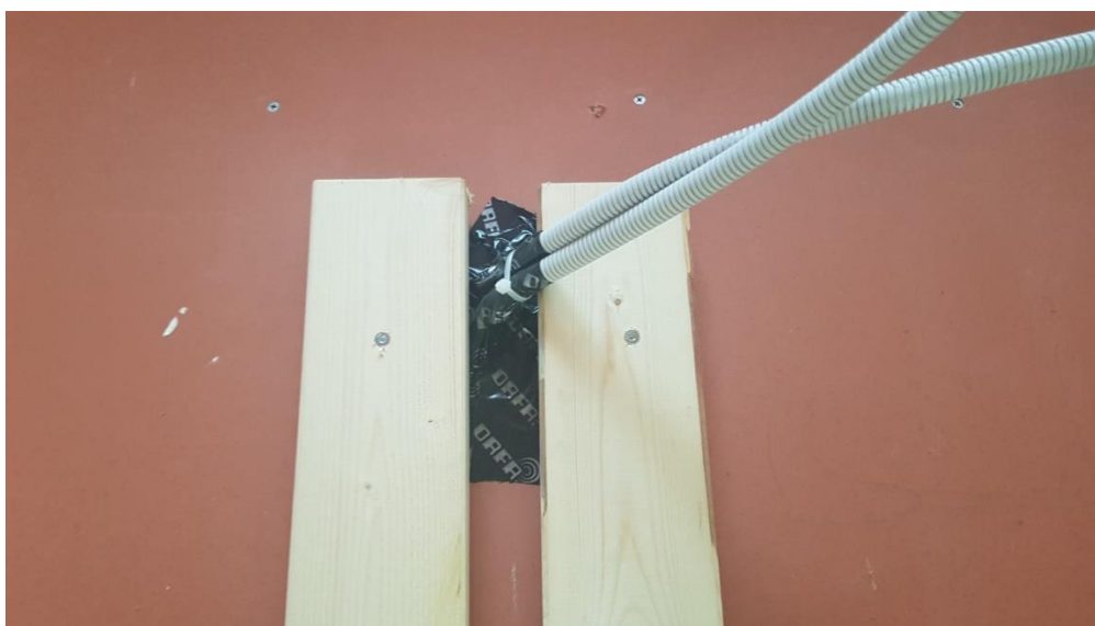
Teip brukt som mansjett på vindsperre mot svalgang
