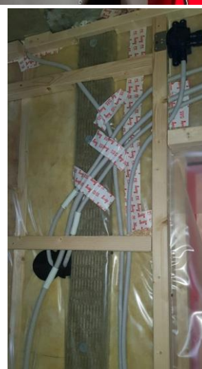
Luftelekkasjer over inngangsdør, luftstrømmer bak gips og ut av el-boks (1.38 m/s) Bilde nederst til høyre er før montering av gips
