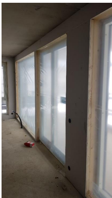
Ferdig gipset, diffusjonssperre trukket forbi vinduer, her har vi skåret hull
