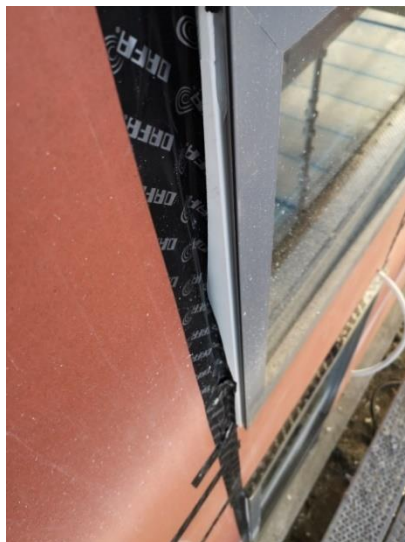
Figur 36 - Teiping av vindsperre, leilighet 201 Foto: Edvard Hogstad
