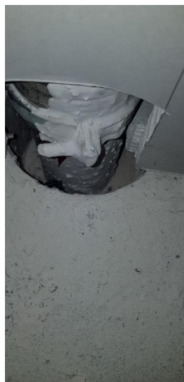
Branntettet rundt soilrør
