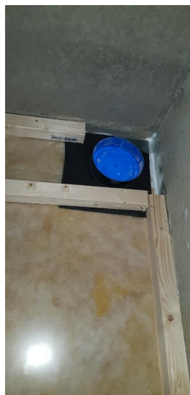
Mansjett for ventilasjon
