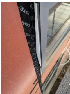
Figur 54 - Teip mot vinduer, leilighet 201 Foto: Edvard Hogstad
