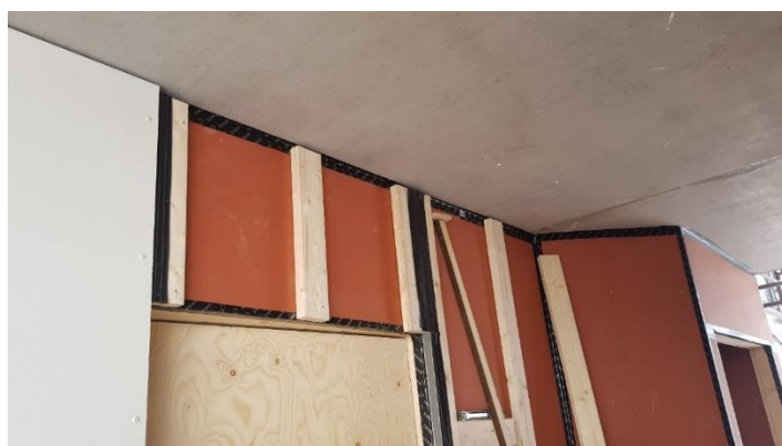
Vindsperre teipet mot dekke
