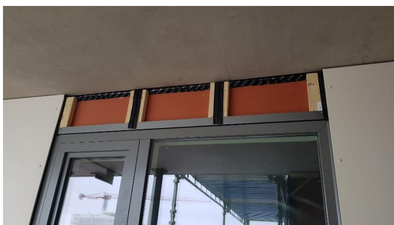
Montasje av kledning
