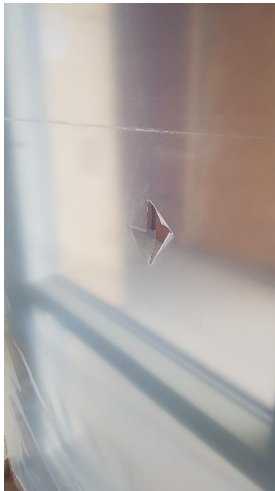
Skåret hull i diffusjonssperre trukket for vindu
