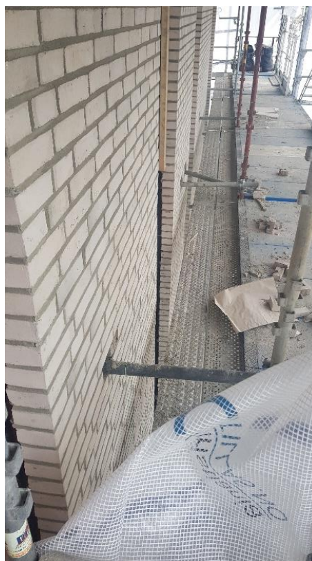
Teglsteinmur på gavlvegg
