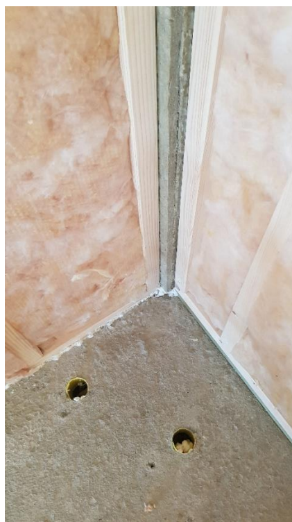
Fuging mot brannisolasjon og dekke
