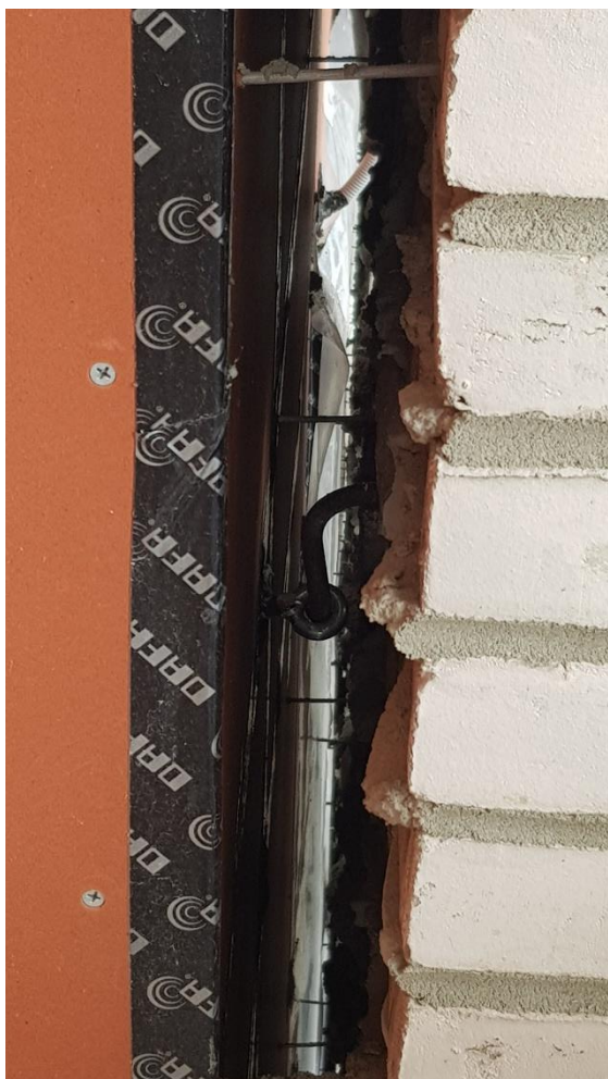
Forankring av teglsteins mur på gavellvegg
