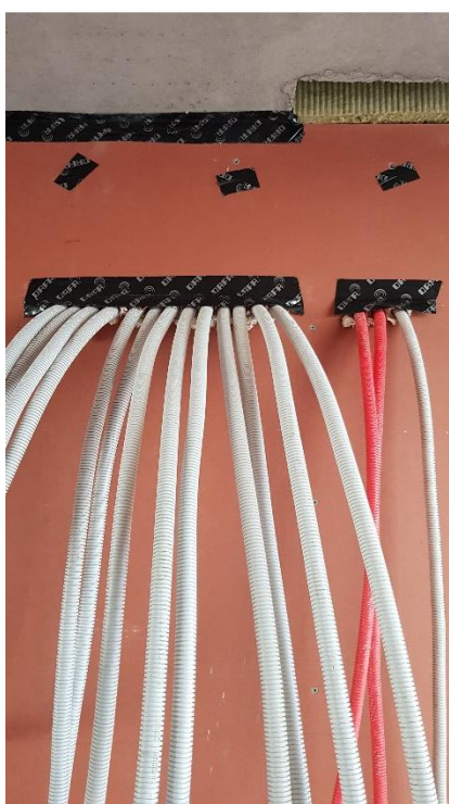
Tetting av k-rør utside
