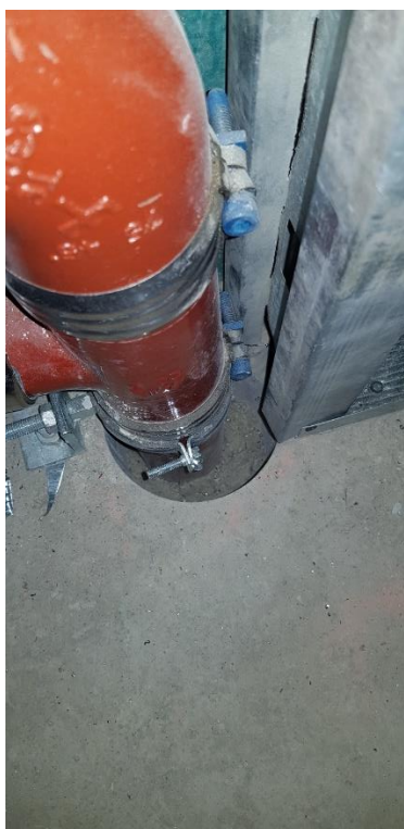
Branntetting av kjerneboret gjennomføring i etasjeskiller
