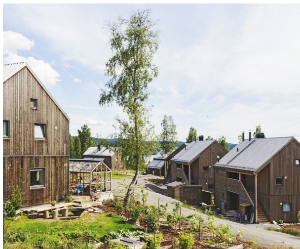
Husene i Hurdal økolandsby er såkalte aktivbus, der hovedfokuset ligger på godt innelima, miljøvennlige materialer og energieffektivitet. Foto: Aktivbus
