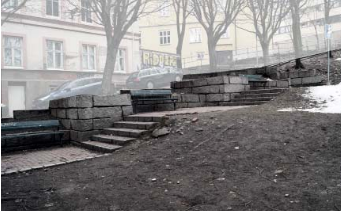
Terrasserte plenarealer med trapper og repos
