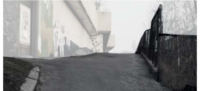
Dårlig sikt til adkomst ved parkering på Brannveien
