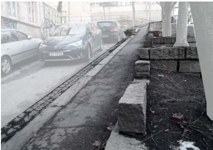
Bratt gangvei som fungerer som "rampe" idag
