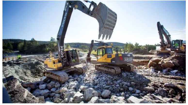
Bilde 56: Anleggsarbeid ved Hamremoen, like sør for Krøderen kro, i tilknytning til etablering av rundkjøring
