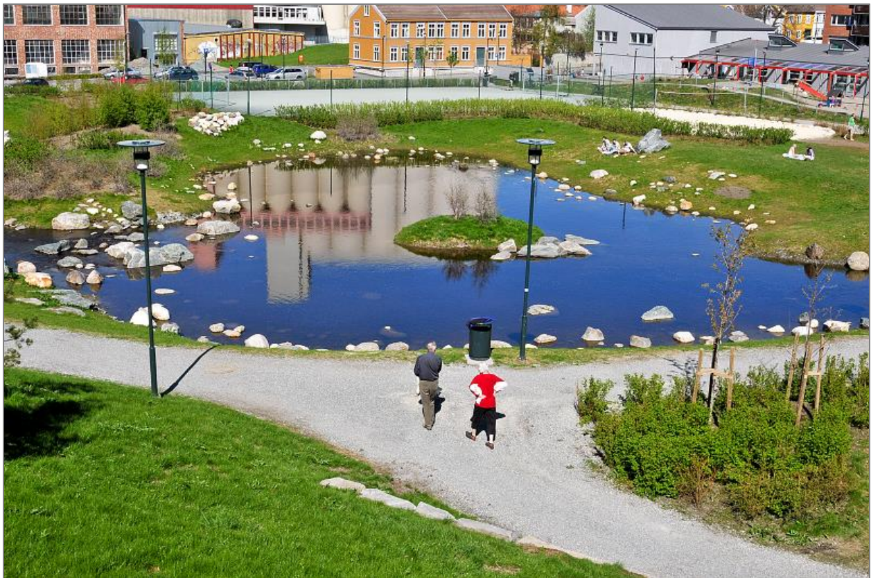
Figur 3.5 Eksempel på utforming av overvannsdam. (Foto: Knut Opeide, bildet er gjengitt med tillatelse fra Knut Opeide).
