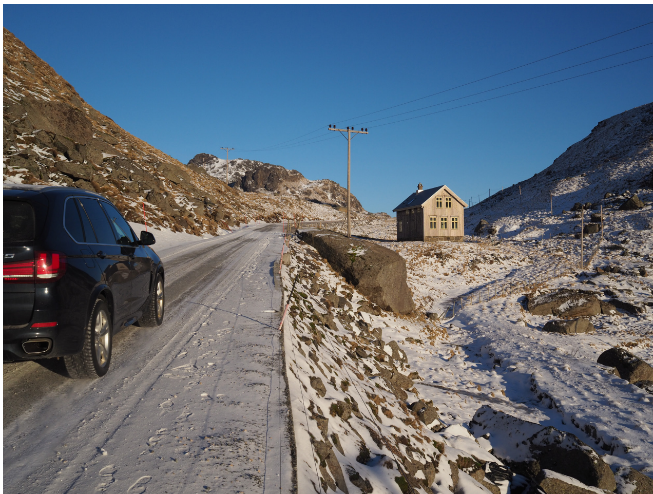
3.17. Vikveien opp mot gamle Vik skole er smal. Deler av strekningen er ikke asfaltert, hvilket gjør den sårbar for slitasje ved mye trafikk. Det er ikke plass til mer enn en bil i bredden, og en betongkant gir støtte til grusveien, men er noen steder falt ut, som i noen partier gjør veien enda smalere.
