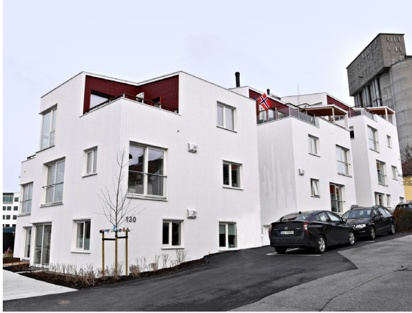
Figur 8: Vindmøllebakken utvendig (Christensen 2019).
