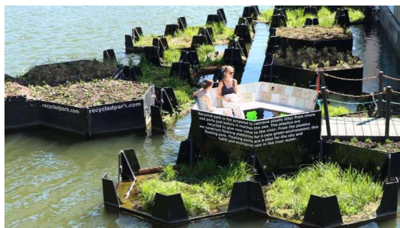
Fig. 3.12: Recycled Park i Rotterdam legger godt til rette for rekreasjon ved at enkelte flåtemoduler tillater gange og opphold.
