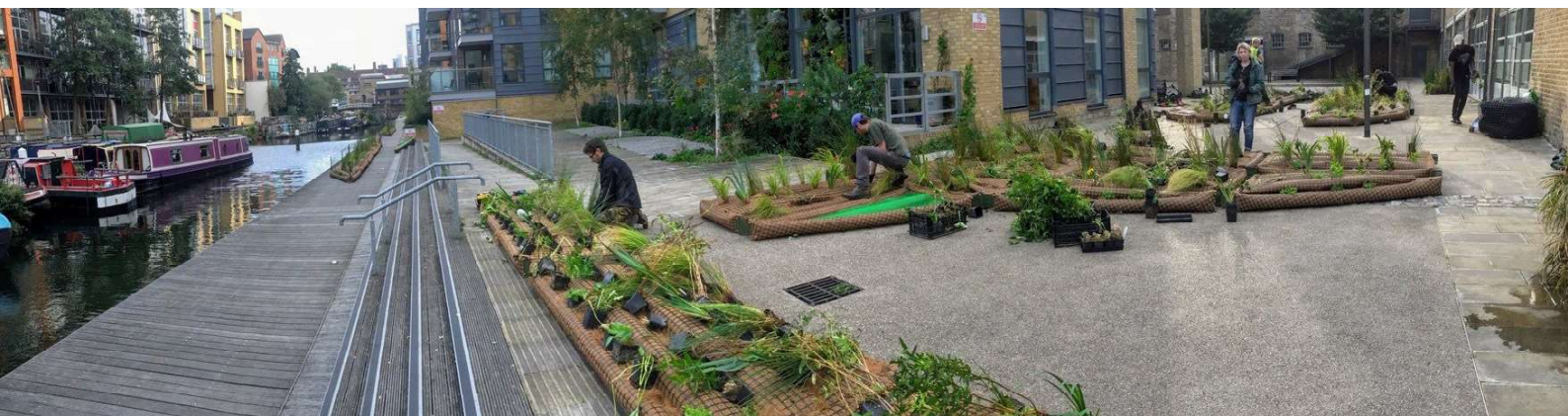
Fig. 4.48: Tilplanting og sammenkobling av vegetasjonsflåtene gjøres på land før de settes på vannet.
