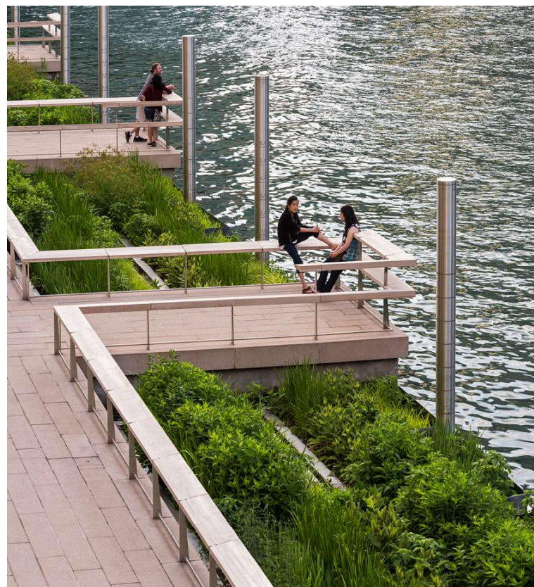
Fig. 3.14: Vegetasjonsflåter langs Chicago river plantet med lokale planter. Pålene forankrer flåtene og tillater flåtene å følge varierende vannstand.
