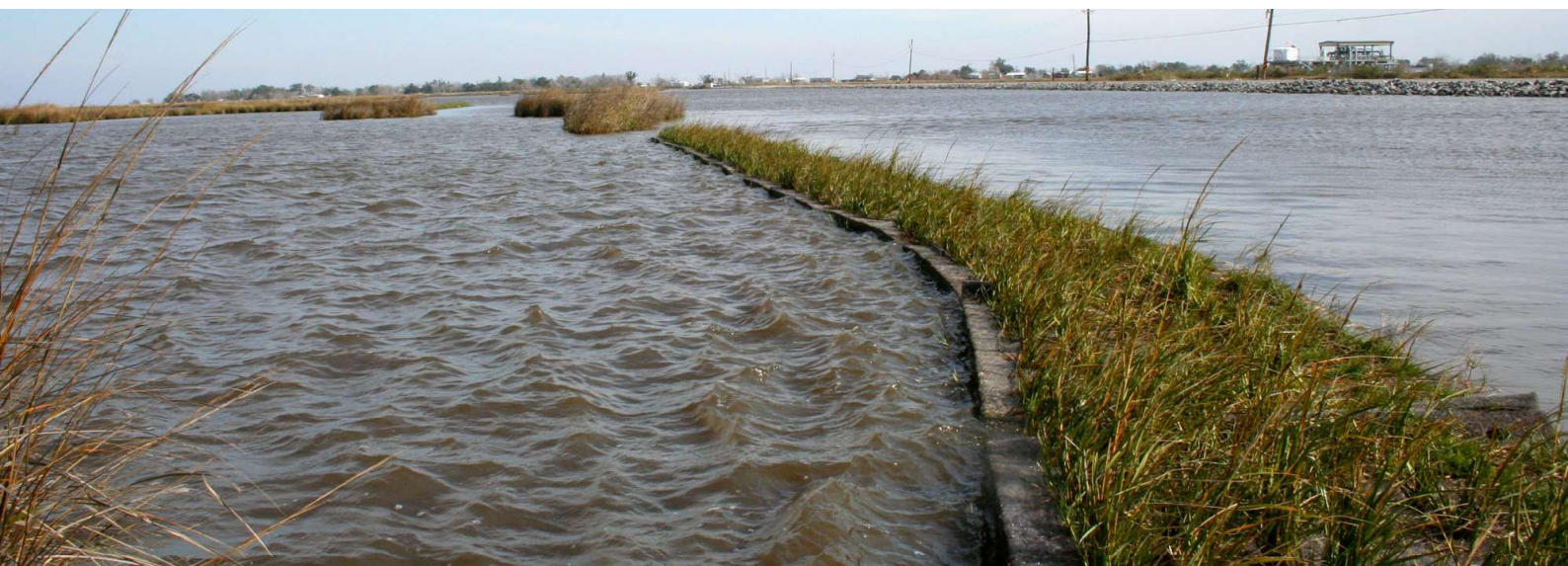
Fig. 3.10: Vegetasjonsflåter kan legges ut som belter for å dempe bølgene utenfor kystlinjer som er spesielt erosjonsutsatt, her i USA ved vegetasjonsflåter av typen BioHaven® Floating Breakwater.
