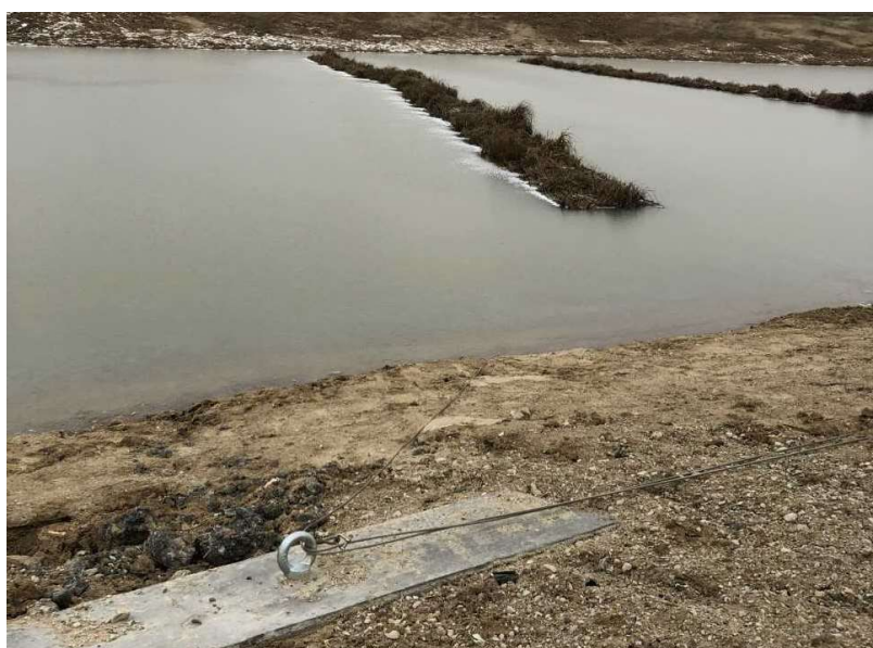
Fig. 4.44: Vegetasjonsflåter forankret med wire i fundament på land. Bilde er fra et regnvannsbasseng i Odense.
