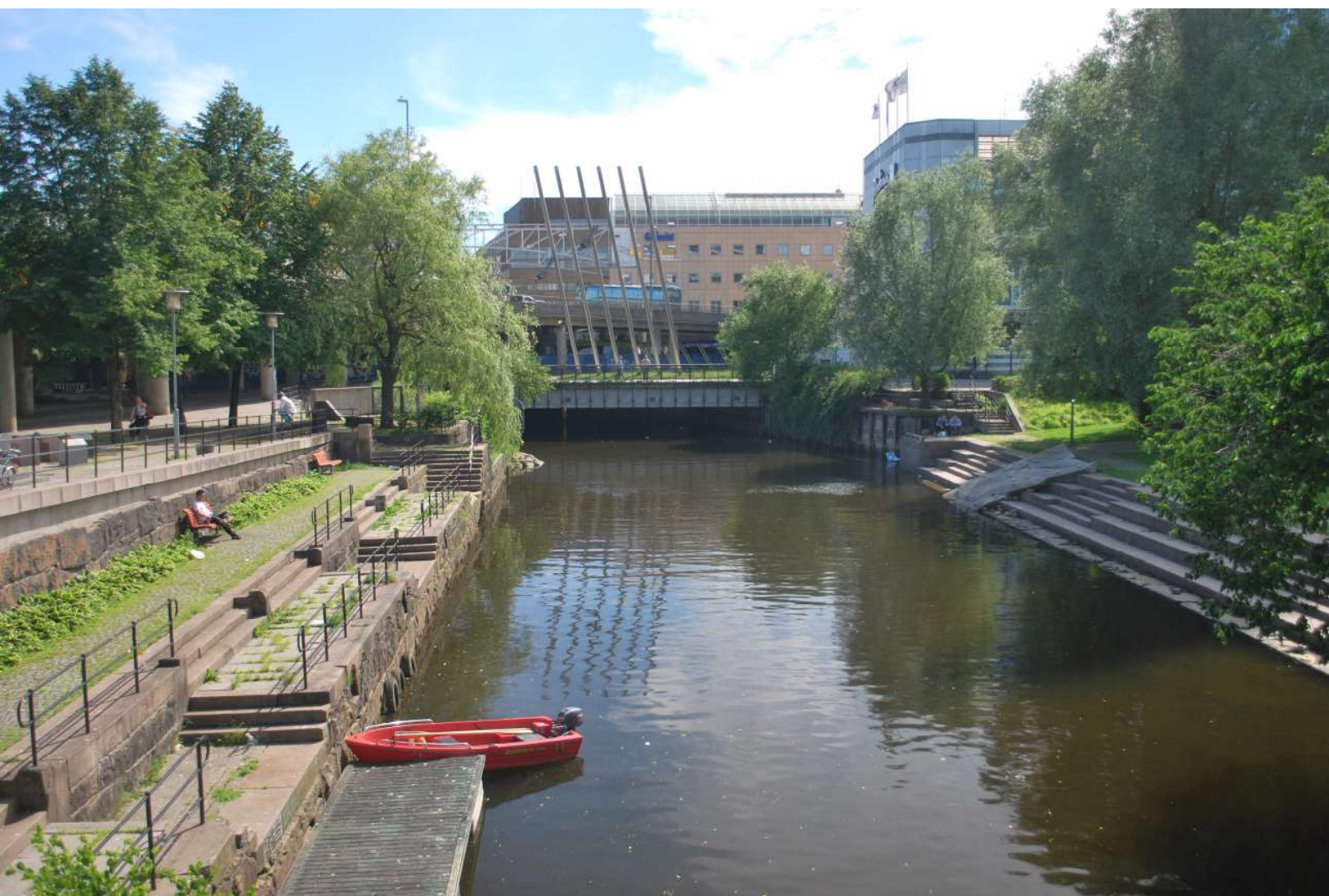
Fig. 1.2: Akerselva i Oslo. Den naturlige overgangen fra land til vann er erstattet med harde kanter som sikrer mot erosjon og gir enklere adgang til vannkanten.
