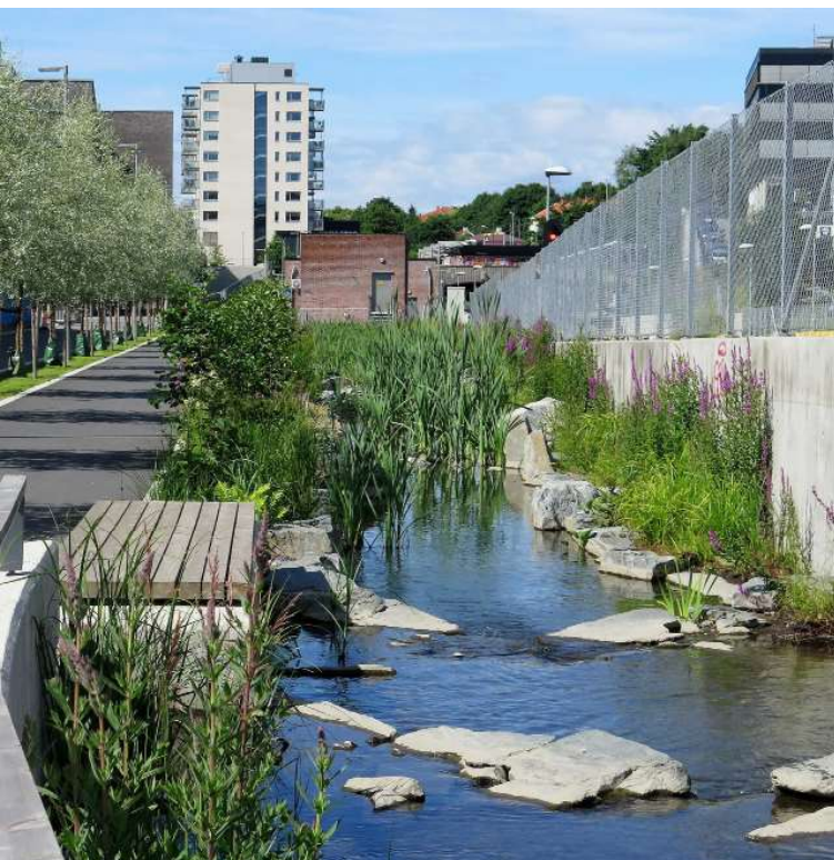
Fig. 1.3: Hovinbekken i Oslo, bekkegenåpning med fokus på flomhåndtering, forbedring av vannkvalitet, biologisk mangfold og rekreasjon.
