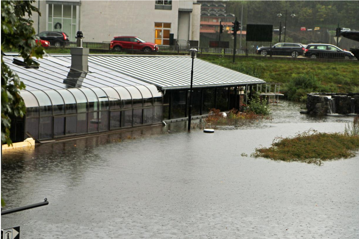
Figur 3: Restauranten Strøm Mat og bar ble fullstendig oversvømt ved ekstremværet. Kilde: NRK
