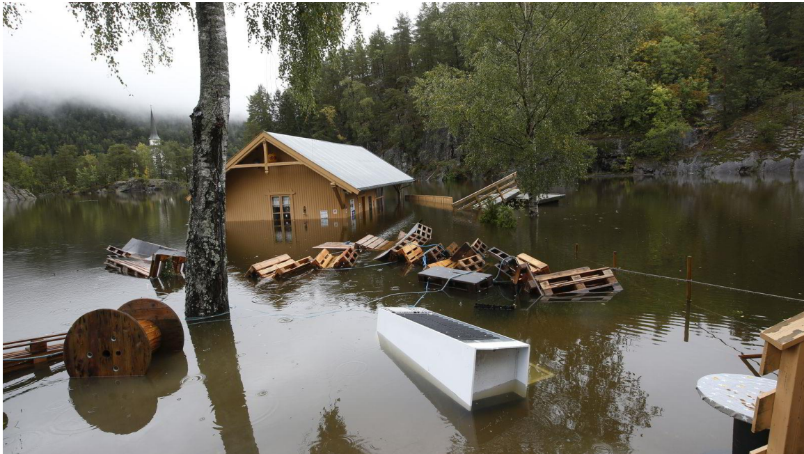
Figur 4: Bildet viser et pakkhus på Skotfoss i Skien etter ekstremværet Petra. Kilde: Dagens Næringsliv
