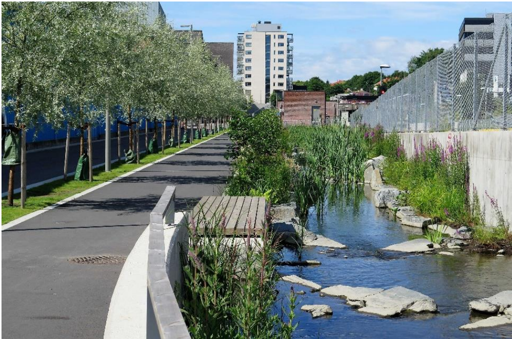
Figur 2: Gjenåpning av Hovinbekken. Kilde: Plan- og bygningsetaten
