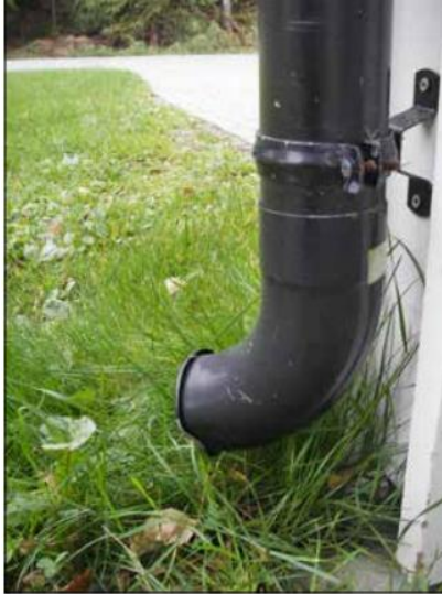
Figur 16: Taknedløp direkte på plen. Kilde: VANN
