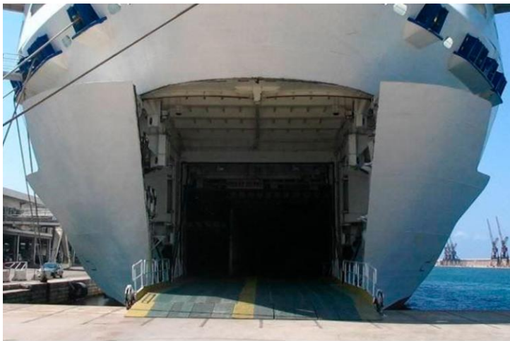
Figur 8: Fergelem på skip som legger til på ro-ro rampe i betong (Fra Moss Havn KF internrapport).
