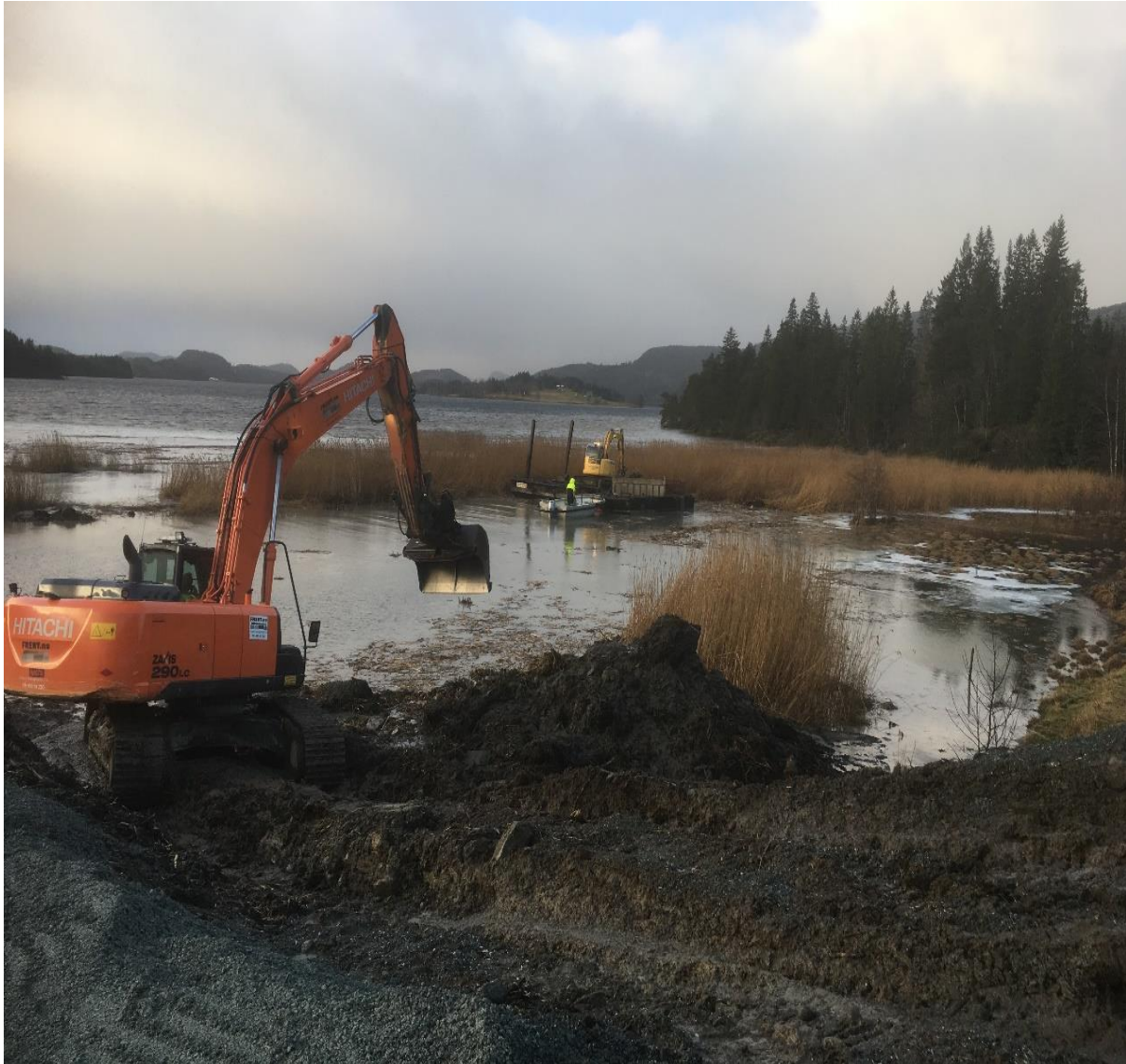
Figur 12. Restaureringsarbeid i Hammervatn naturreservat, 23.01.2017. Fjerning av akkumulert organisk materiale og kutting av taksør. Gravemaskin lengst unna i bilde tar opp masse og plasserer massen på lekteren, mens gravemaskin lengst frem i bildet skufler massene over til lastebil. Gjennomført av lokal entreprenør. Foto: Hilde Ely-Aastrup, Fylkesmannen Trøndelag.
