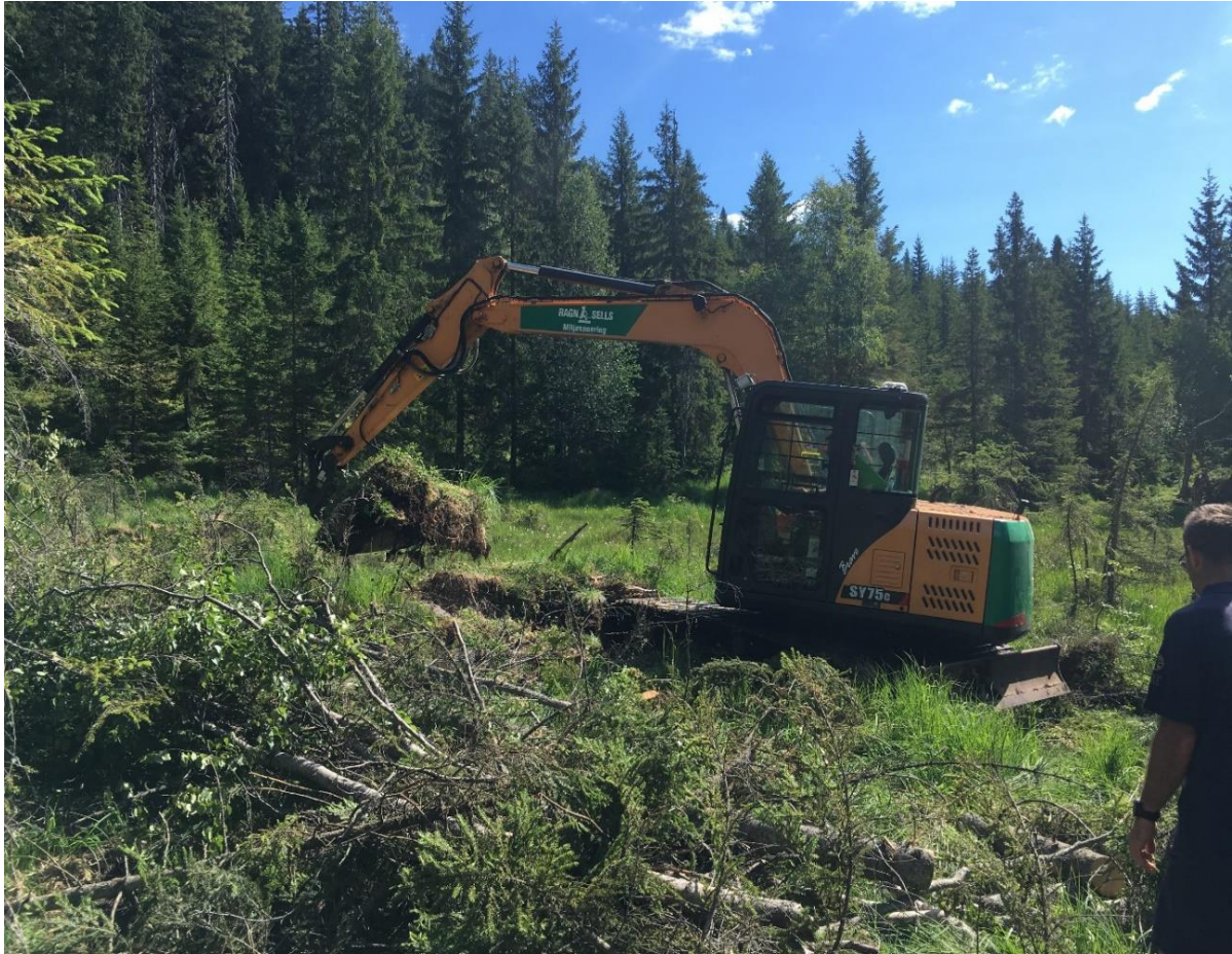
Figur 5. Etablering av demning ved bruk av gravemaskin. Skjeggerudsetra, 26.06.2018.
