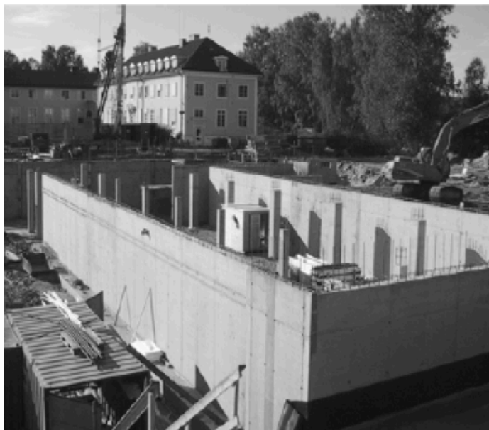
Figur 3-7. Bygging av ny videregående skole i Sørumsand, Oslo (Mehus et al., 2002).
