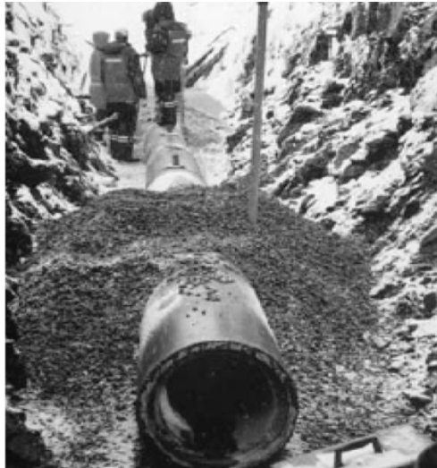
Figur 3-9. Bruk av resirkulert tilslag som omfyllingsmateriale (Mehus et al., 2002).
