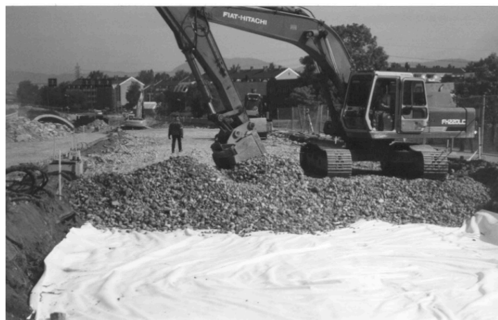
Figur 3-10. Bruk av resirkulert tilslag som forsterkningslag, Svartdalstunnelen, Oslo (Mehus et al., 2002).
