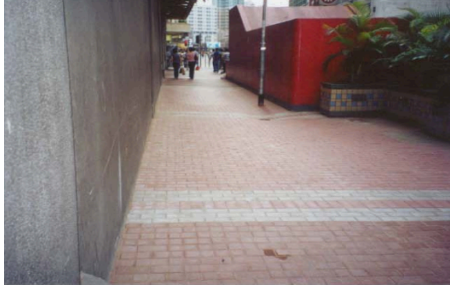
Figur 3-11. Resirkulert tilslag som belegningsstein (The Hong Kong Polytechnic University PolyU, u.å.).
