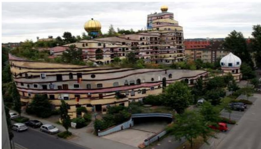
Figur 2-1. Boligbygninger “Waldspirale” i Darmstadt, Tyskland (Malešev et al., 2014).
