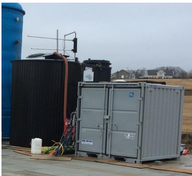
Figur 5. ABR med styringskontainer. (Foto: John Morken)
