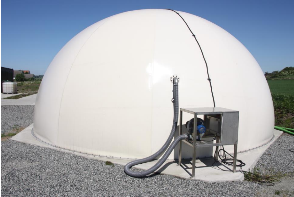
Figur 6. Gasslager. (Foto: Odd Jarle Skjelhaugen).
