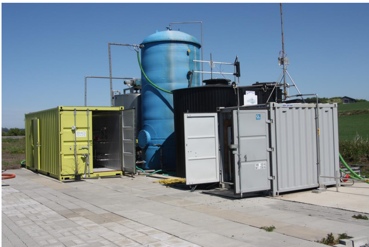
Figur 4. UASB-reaktor (blå reaktor). Bildet viser også plassering av styringskontainer til UASB/perkulering (grønn kontainer til venstre for UASB) og ABR (svart reaktor til høyre for UASB). (Foto: Odd Jarle Skjelhaugen).
