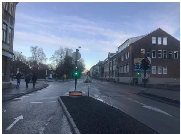
Sykkelfeltet er plassert mellom fortau og bussholdeplass. I lyskrysset er det satt opp lysregulering også for syklister.
