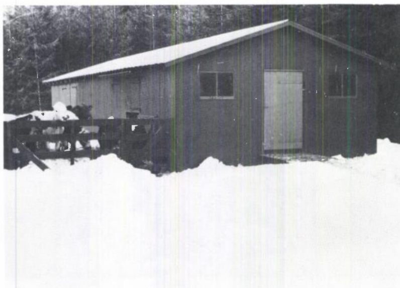
Fig. 5. Okseskuret med pelekonstruksjon var funksjonelt lik halmskuret, men konstruktivt en nyskapning.
