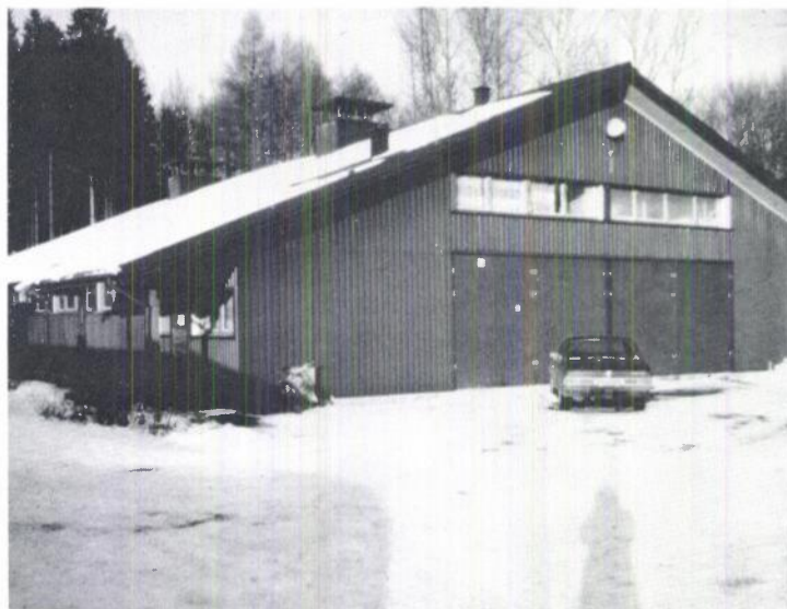
Fig. 10. Grishuset fra 1974 ble planlagt med tanke på forsøksvirksomhet. Det har 4 avdelinger og eget smågrisrom. I andre etasje er det instrumenteringsrom i tilknytning til en høgtliggende observasjonsgang.
