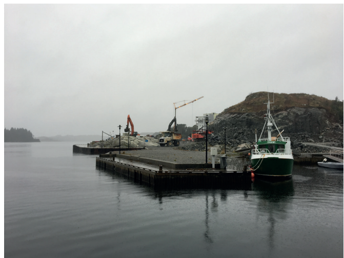
Figur 18: Prestaneset sett fra utenfor Svømmehallen- store inngrep sikrer allmenn tilgjengelighet
