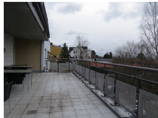
D. (Tatt mot øst, fra sørsiden av bygget) Bildet viser kantineverandaen i tredje etasje, som er romslig nok til å gå små turer på.
