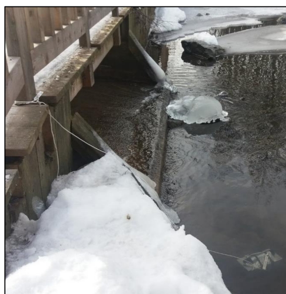
Figur 3.8: Logger nr. 1 festet godt i hyssing som er bundet med broen. Bildet er tatt 08.02.18.
