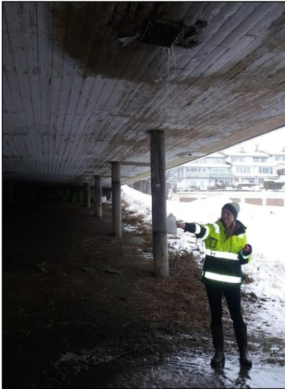
Figur 3.2: Vannprøvetaking under broen. Bildet er tatt 31.01.18.
