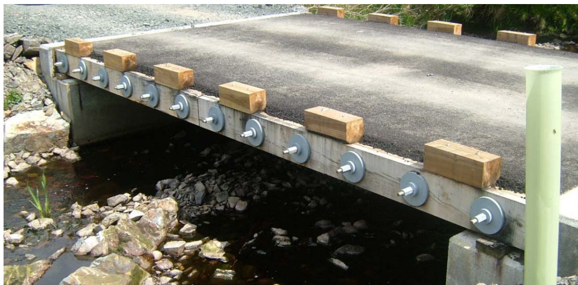
Figur 2 - Tverrspent tredekke som hovedbæring. (Dr. Freedman, hentet 10.03.2018)
