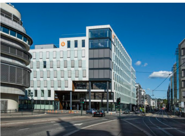
Fig. 64: Statoil Fuel & Retail kontorbygg, fasade fra Teaterplassen (Vestre, u.å.).
