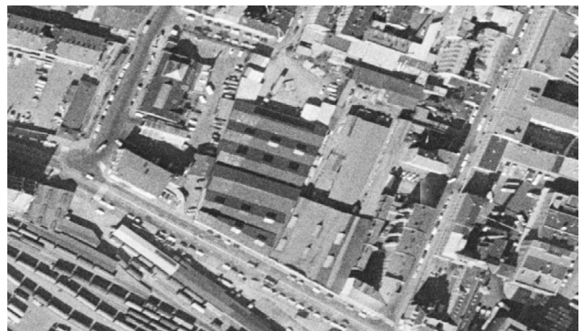
Fig. 49: Plansituasjon i 1971. Sakte men sikkert starter sanering og regenerering av området (ibid.).
