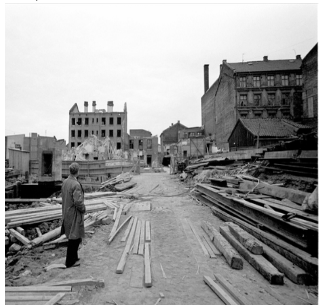
Fig. 39: Saneringsgårder på Grønland, datert 1961 (Oslo-bilder, u.å.).
