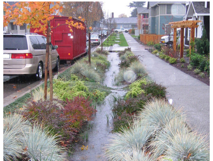
Figur 3.3. Bilde illustrer et eksempel på en bioswale som er anlagt langs en vei med boligbebyggelse på andre siden.
