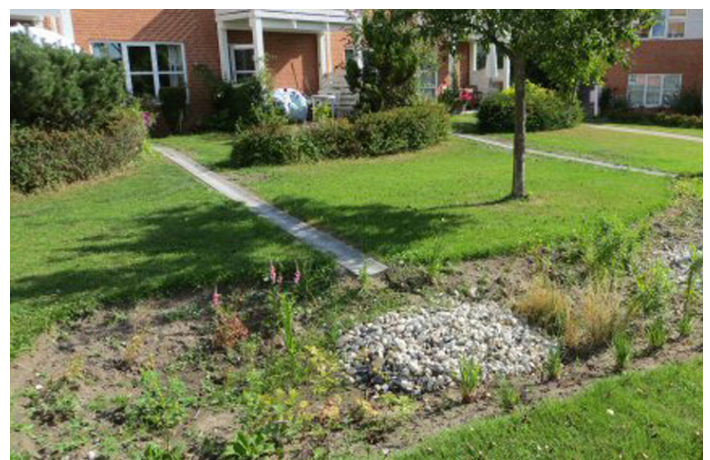
Figur 3.9. Bilde illustrerer hvordan overvannet blir infiltrert i grunnen ved bruk av både gressarealer og regnbed.
