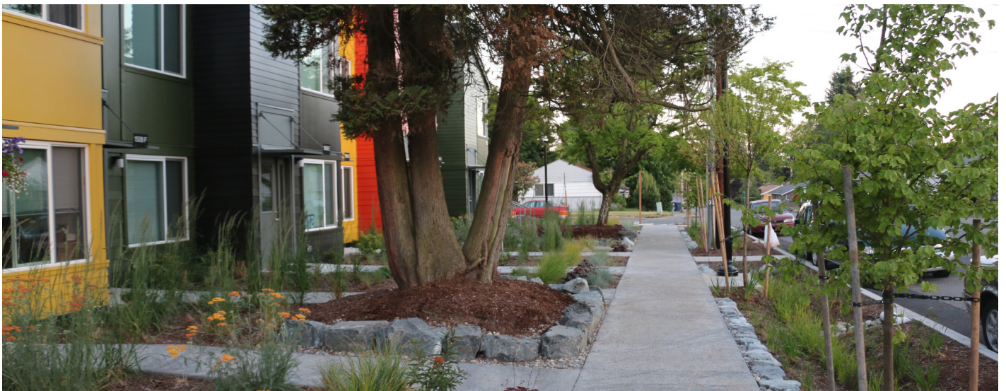
Figur 2.32. I dette boliområdet er det blitt bruk flere typer overvannstiltak som f.eks. minimalt med harde og tette flater som frugjør arealer til fordrøyning og infiltrasjon.
