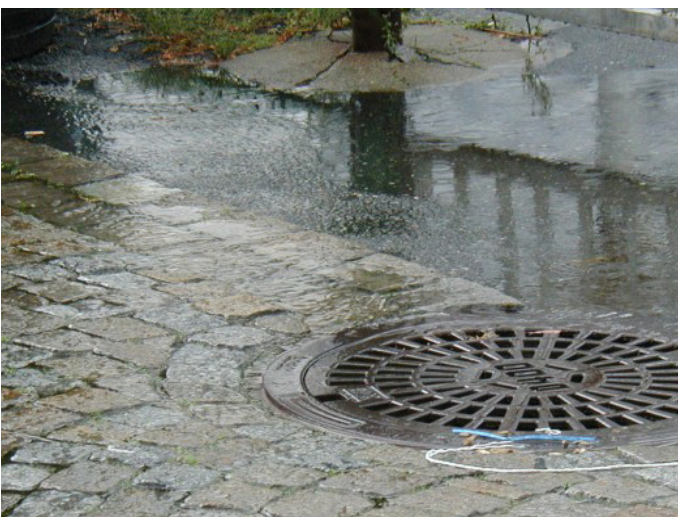
Figur 2.3. Bildet illustrerer hvordan overvannet ofte blir håndtert ved at det blir ledet mot og ned i gatesluk i byer og tettsteder.
