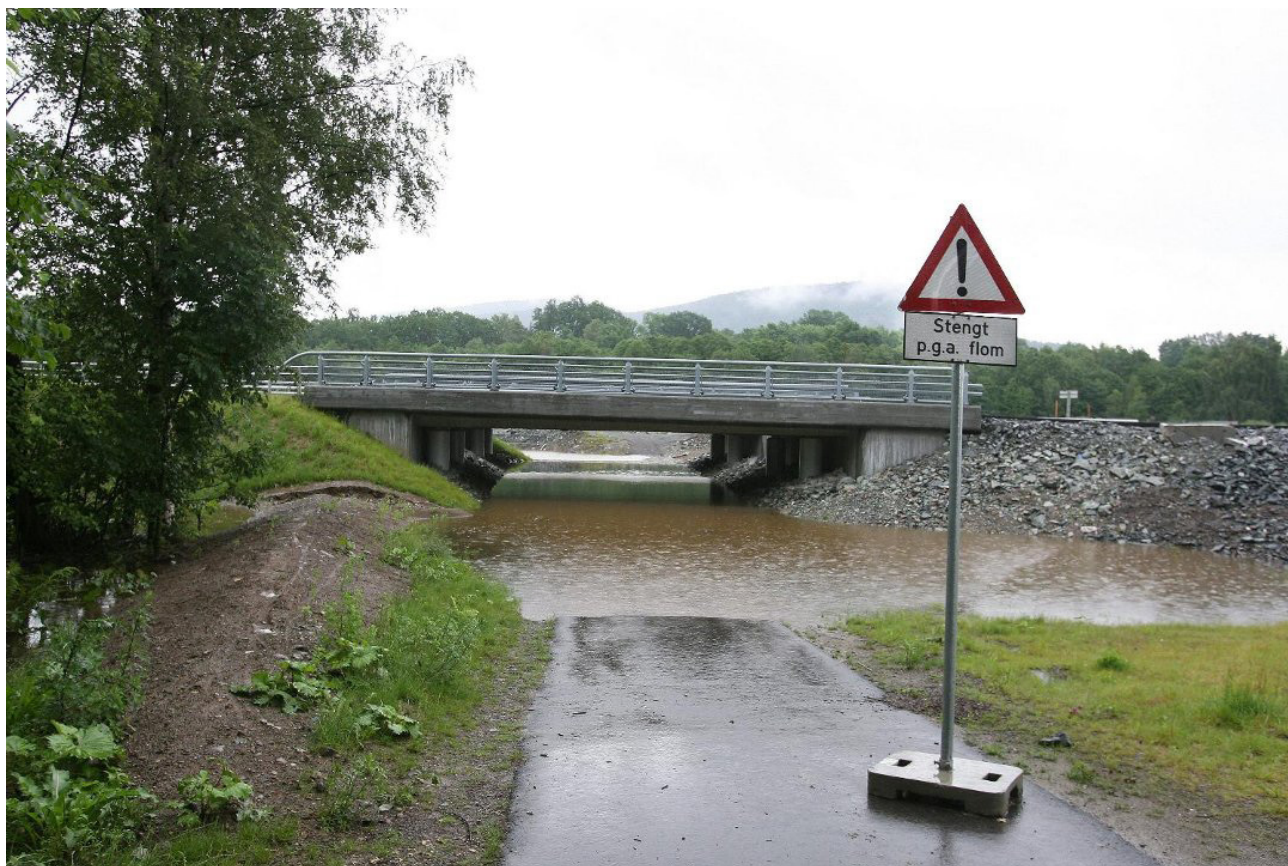
Figur 2.33. Flom ved E16 på Vøyenenga. Dette er et godt eksempel på hvordan overvannet kan være et problem.
