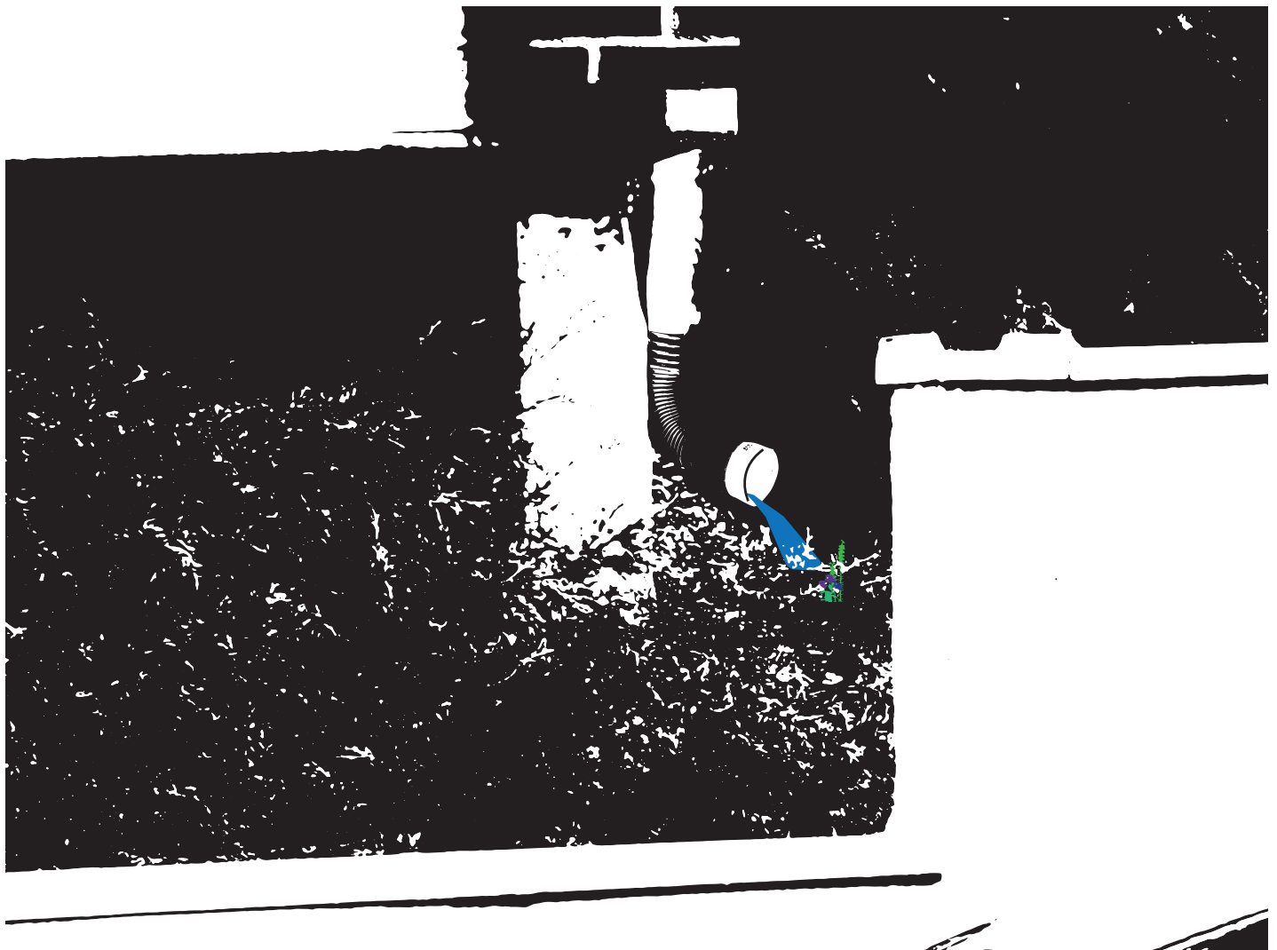
Figur 5.24. Taknedløpene skal kobles fra og takvannet skal ledes mot bioswalen langs den eksisterende hekken og muren.
