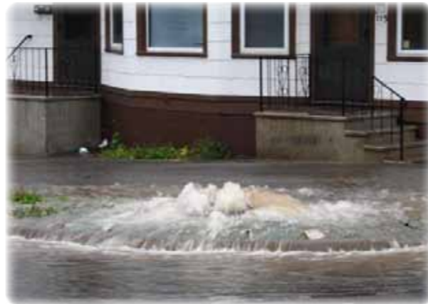
Bilde 1.7. Overløp i fellessystem kan medføre at urensset vann renner ut i gatene og ender opp i vassdrag og sensitive vannkilder. (Foto: http://www.lakesuperiorstreams.org )
