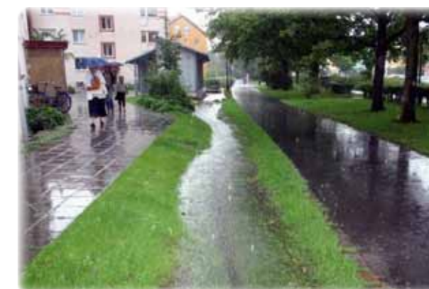
Bilde. 1.13. Gresskledd vannrenne/bioswale. (Foto: Malmø kommune)
