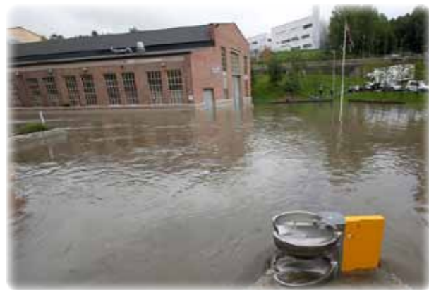
Bilde. 1.1. Kvernbyen i Oslo, hvor det ble oversvømmelse etter at en kulvert gikk tett. (Foto: Vidar Ruud/NTB scanpix)
