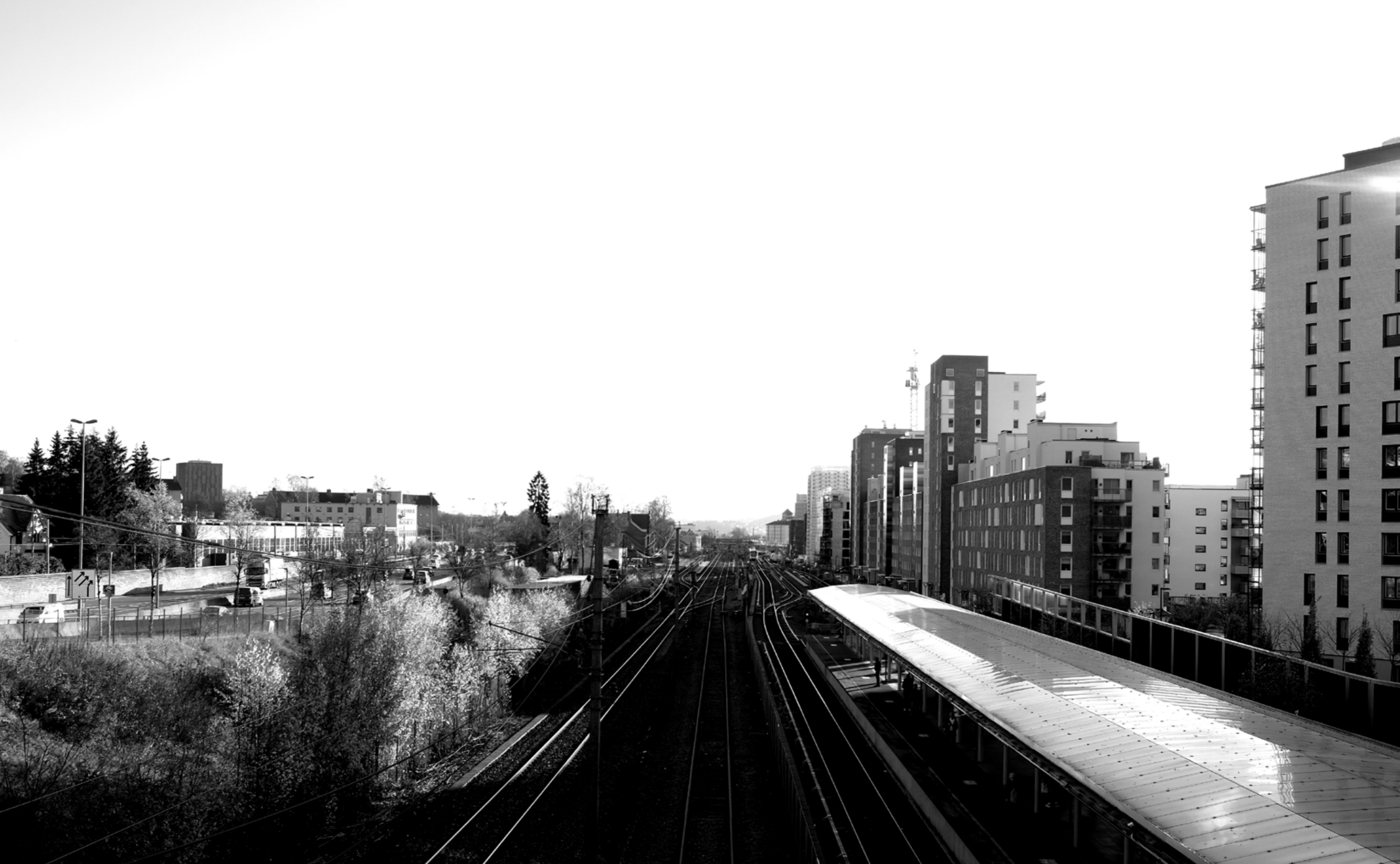
Bilde. 3.1.6. Tatt fra Grefsenveien(broen) og illustrerer godt barrieren som veianlegget utgjør. Nederst til høyre ser vi Storo T-banestasjon. (Foro: Lars Ove Nygård. 27.05.2018)
