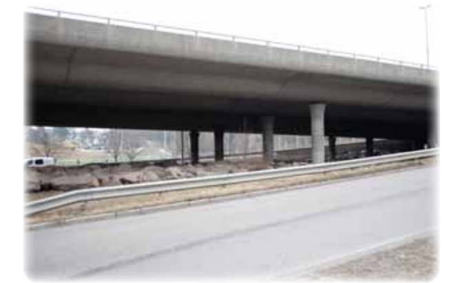
Bilde. 2.4.9. Ved broen finnes det kun gresskledde restarealer
