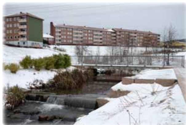
Bilde. 1.11. Gjenåpnet bekk/ flomvei med småfosser. Hovinbekken i Bjerkedalen park. (Foto: Lars Ove Nygård 2017)
