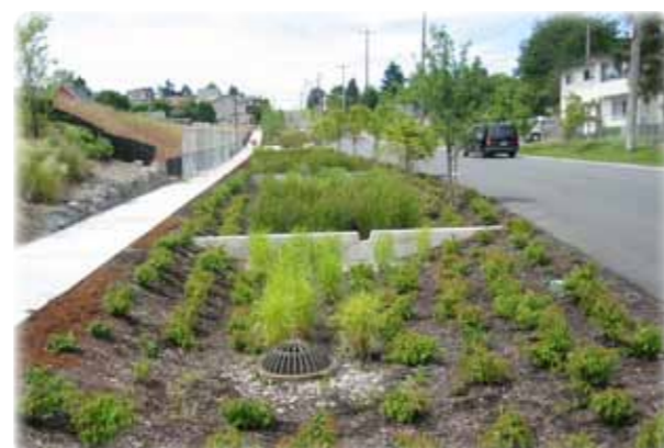
Bilde. 1.10. Bioswale/ vegetasjonskledd grøft med terskel for tilbakeholdelse av vann. 2015. (Foto: http://www.holemanlandscape.com )
