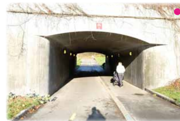
Bilde. 1.2.1.19. Undergangen inn mot Faherlund
