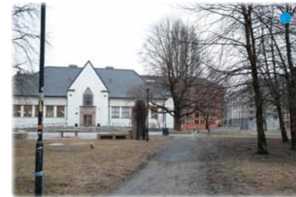
Bilde. 2.1.42. Schous plass fra sørsiden
