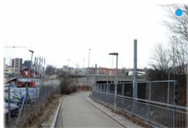
Bilde 2.1.7. Gangvei på vestsiden av Sinsenkrysset som fortsetter under veianlegget frem til Sinsen trikkeholdeplass og Muselunden
