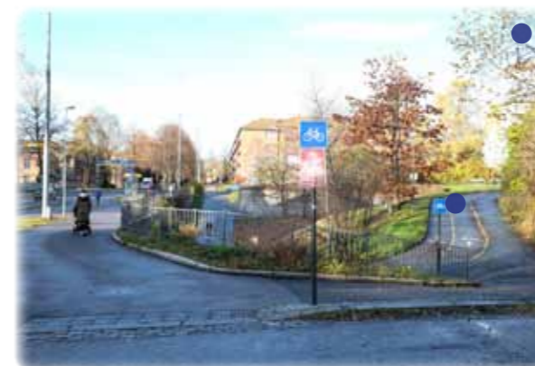
Bilde. 2.1.24. På bildet ser vi sørsiden av Fagerlund parkområde. Turveiundergangen ligger i forsenkningen midt på bildet
