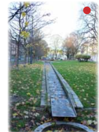
Bilde 2.2.8. Vannet ledes tilbake til sirkulasjonssystemet tilbake til kulvert
