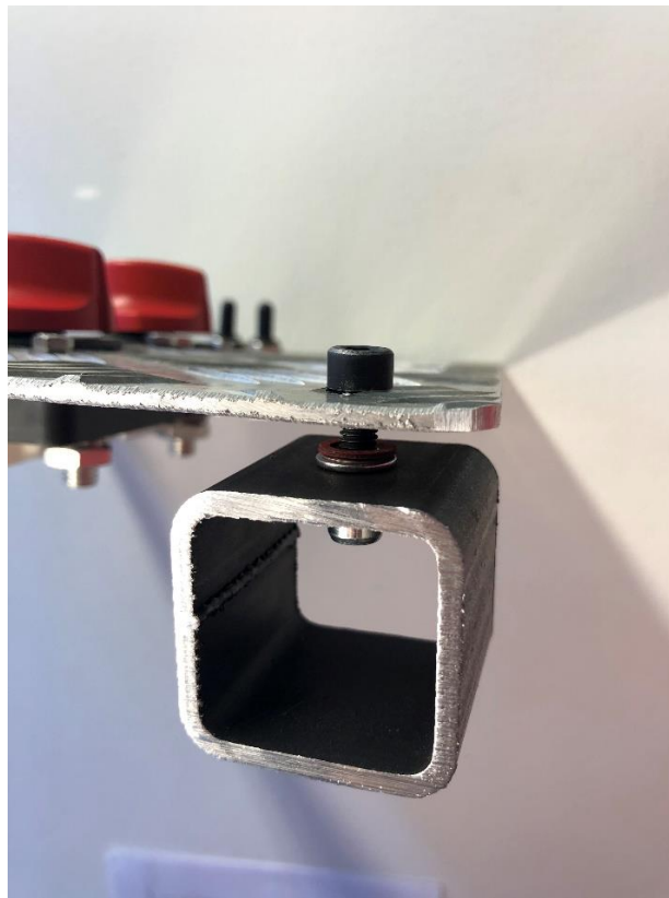
Figur 99: Det galvaniske skillet ved bruk av blindnaglemutter og fiberpakning mellom stålprofilen og dørkaluminiumsplatene
