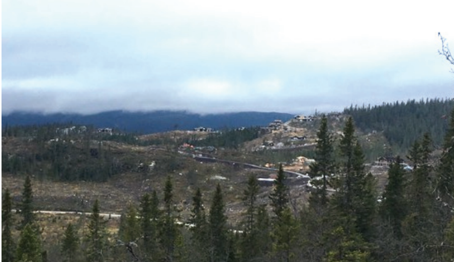
Figur 4-1 Et nytt felt med fritidsbolier er under oppføring. Fra Eggedal ved Djupsjøen. Foto: Beate Aase Heidenreich
